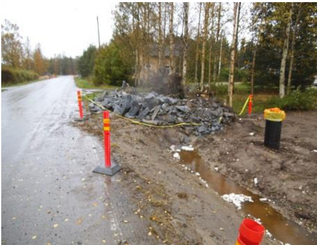
Kuva 5. Työmaa sijaitsi asutusalueella.
