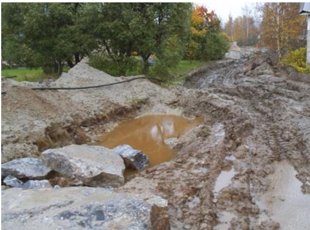
Kuva 7. Vesi teki rakentamisesta haastavan.
