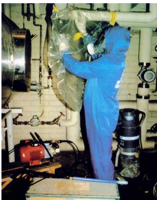
Kuva 23. Purkupussimenetelmä [26]
