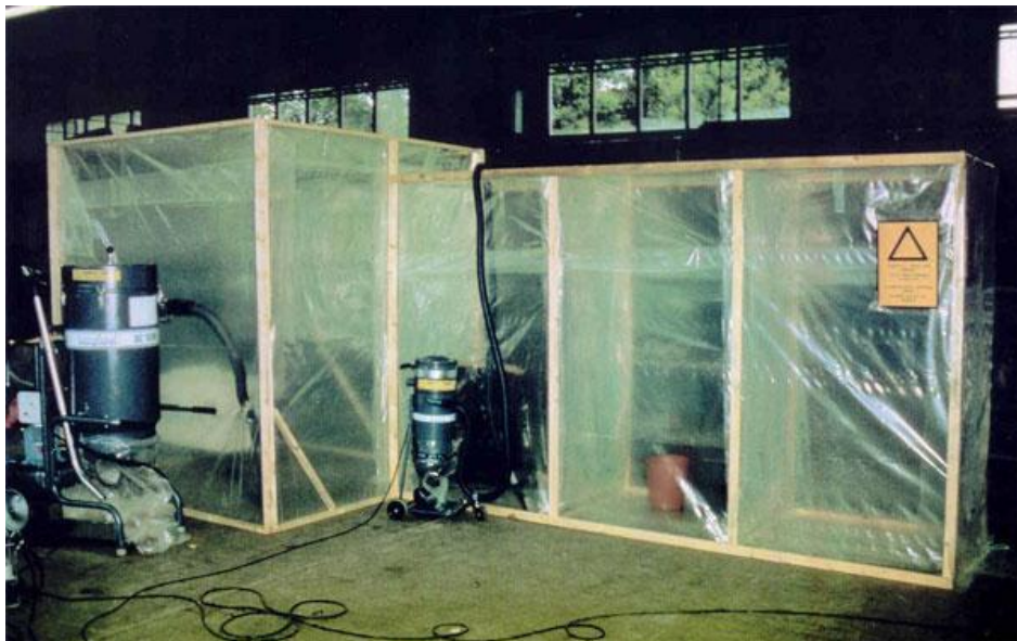
Kuva 22. Osastoitutila jossa näkyy myös alipaineistusimuri ja varoituskilpi [26]
