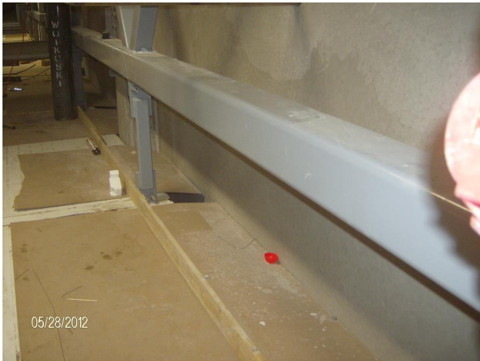
Kuva 6. Jalkalista tavaroiden putoamissuojana [27]
