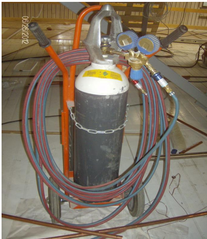
Kuva 15. Nestekaasupullo on oikeaoppisesti telineeseen kiinnitettyä [27]
