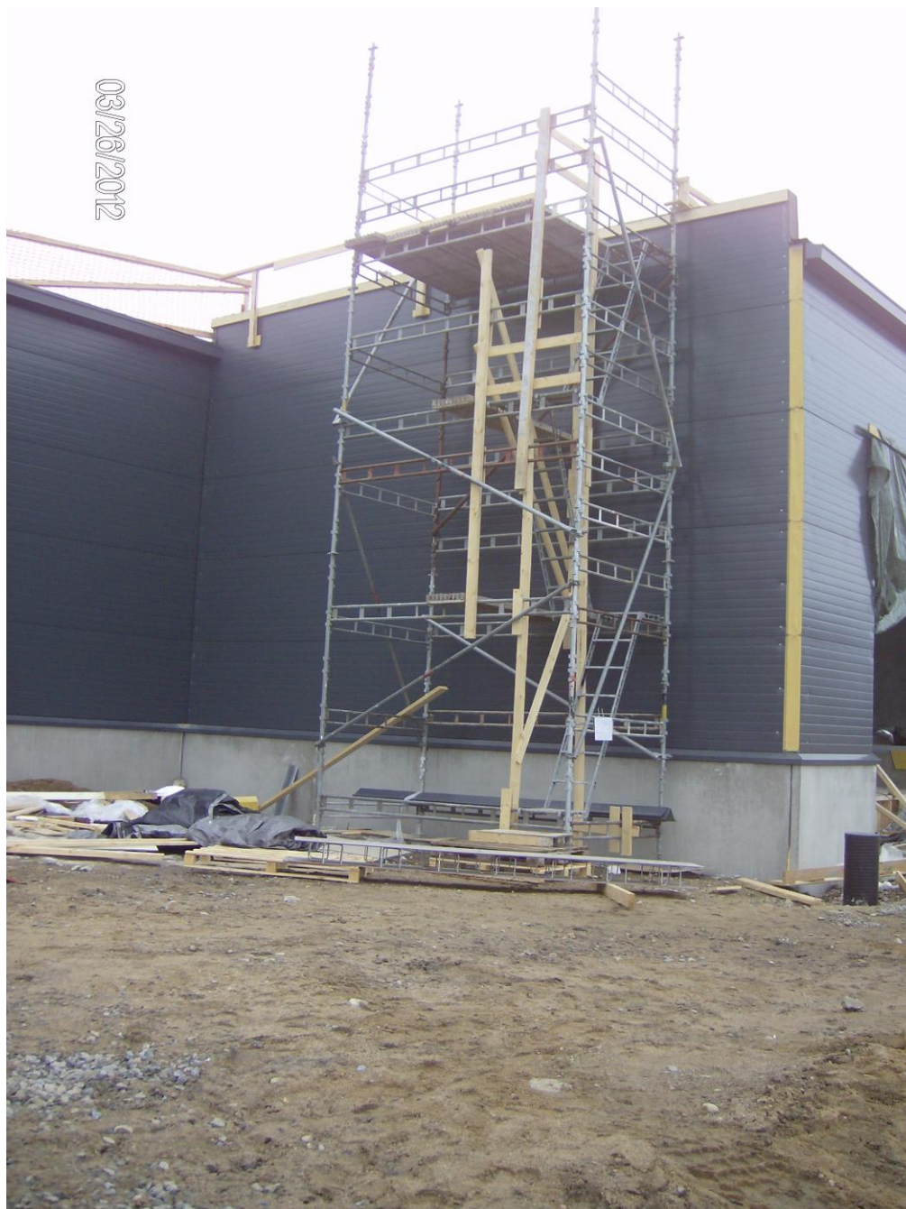
Kuva 12. Kulkutienä teräksiset telineet [27]
