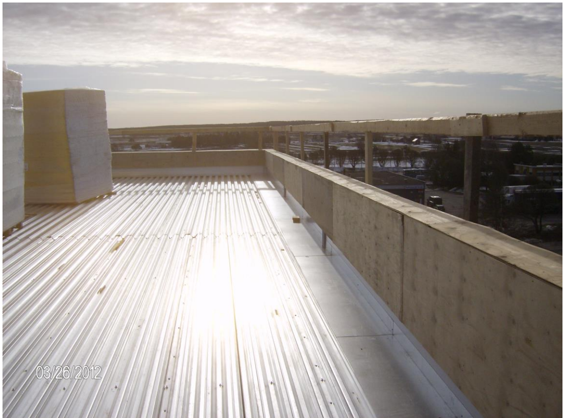
Kuva 19. Siistinä pidetty työmaa on kaikkien etu [27]
