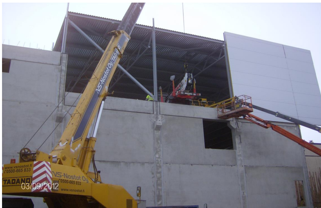
Kuva 11. Autonosturilla nostetaan henkilönostinta IV-konehuoneeseen kuukulkijan avustuksella [27]
