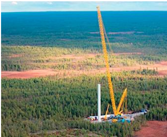
Kuva 2. Tuulimyllyn pystytys Iissä, jossa käytössä Demag CC 6800 1250T (Havatorin www-sivut 2013, hakupäivä 30.1.2013)
