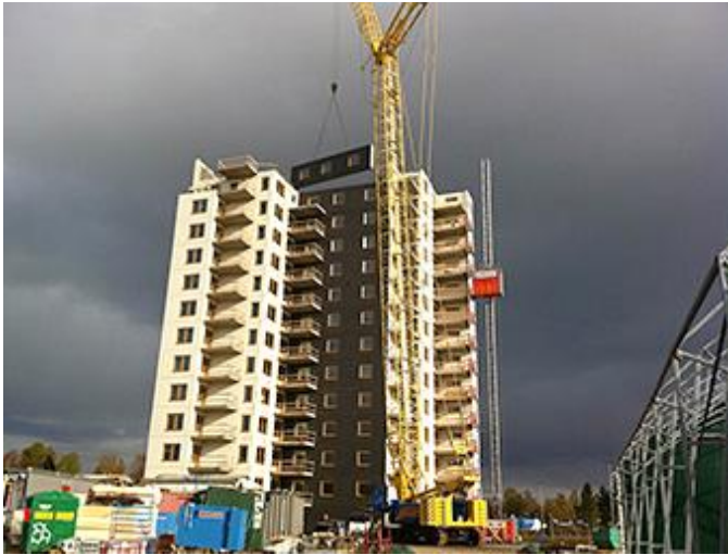
Kuva 4. Kerrostalon elementtiasennus Ruotsissa, jossa kalustona Havatorin ristikkopuominosturi (Havatorin www-sivut 2013, hakupäivä 30.1.2013)
