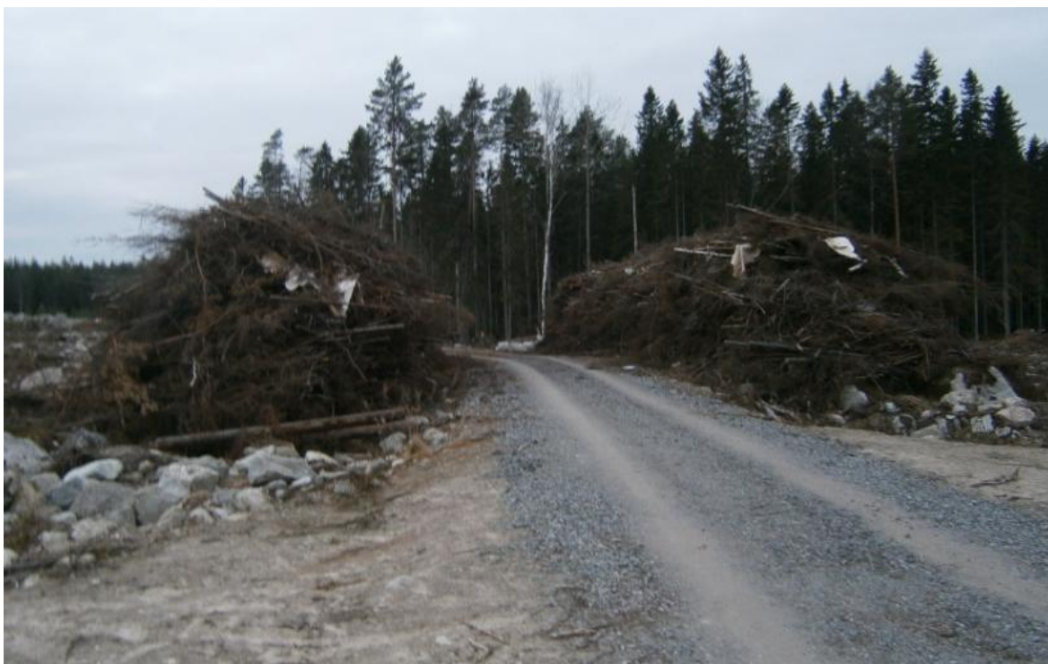
Bild 7. Traven har placerats intill en nybyggd skogsväg på grovkornig mark. (Foto: M. Svartsjö)
