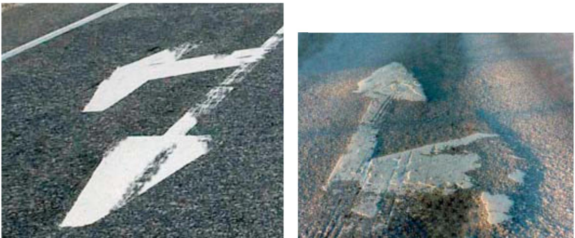
Kuva 13. Maalauksien kuntoluokat 3 ja 2 (Tiehallinto 2004d, 11).
