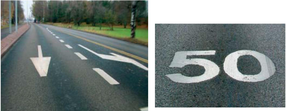
Kuva 12. Maalauksien kuntoluokat 5 ja 4 (Tiehallinto 2004d, 11).
