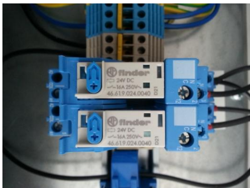
KUVA 16. Välireleet (Kuva: Kare Rantanen 2013)
