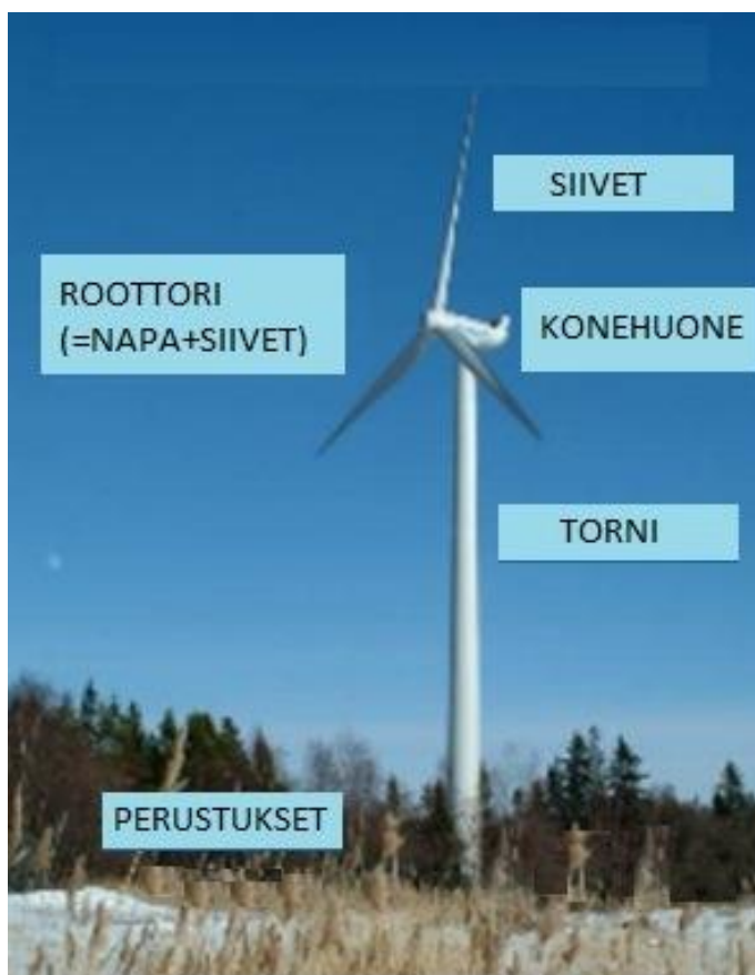
KUVA 11. Millainen on tuuliturbiini. (Tuulivoimatieto, Suomen tuulivoimayhdistys ry.)
