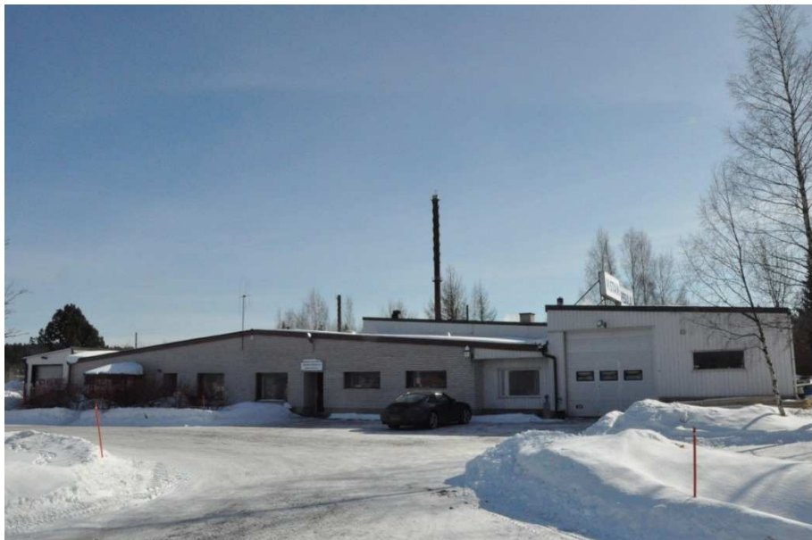
Kuva 1. Vistan Pesula Oy:n julkisivu länteen.
