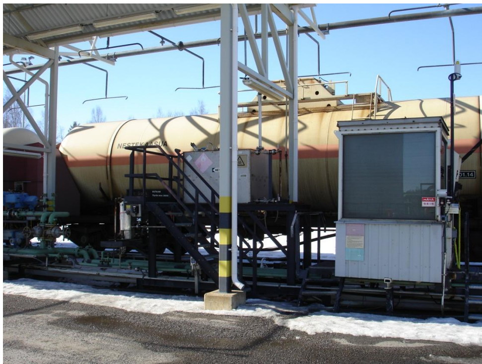
Kuva 3. Lastauslaituri, oikealla kuvassa on "valvomokoppi".
