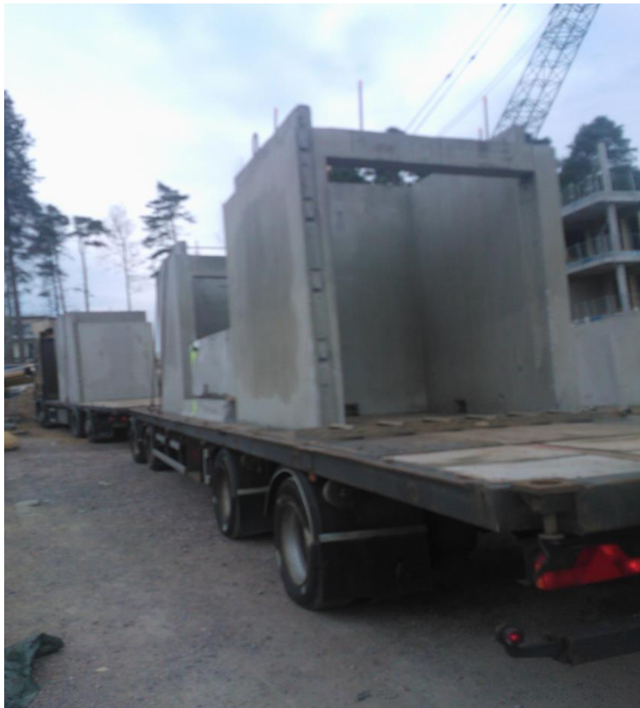
Kuva 3. Hissielementtien kuljetusta.
