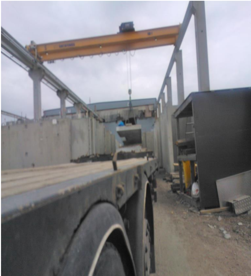
Kuva 5. Taso laatan nostaminen elementti tehtaalla.
