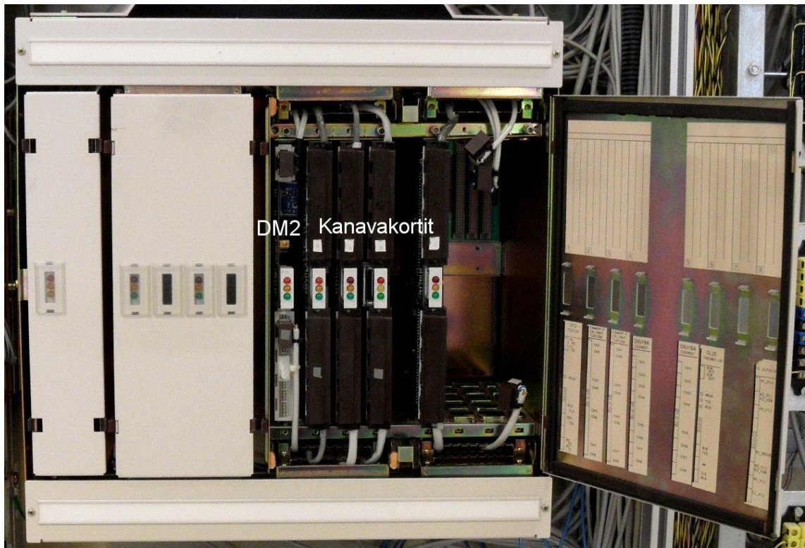
Kuva 15. 2Mbit/s MUX-laite DM2 ja 4 kpl kanavakortteja.
