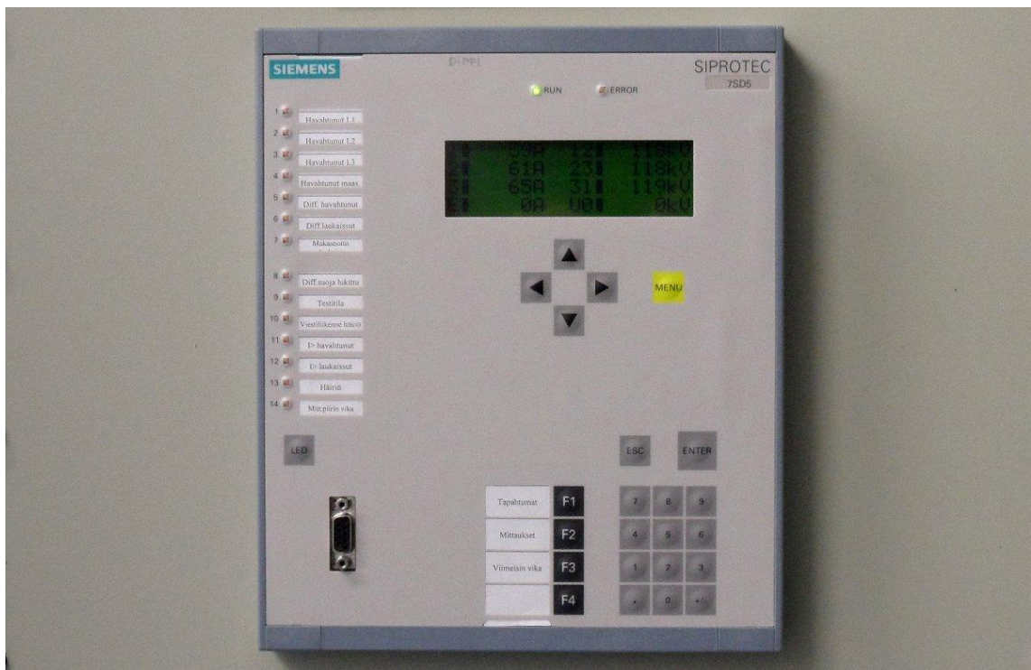
Kuva 22. Numeerinen differentiaalirele Siemens SIPROTEC 7SD5
