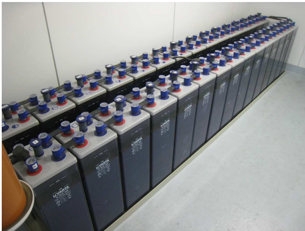
KUVA 7. Asetinlaitteen lyijyakusto (Jani Rissanen 2013.)
