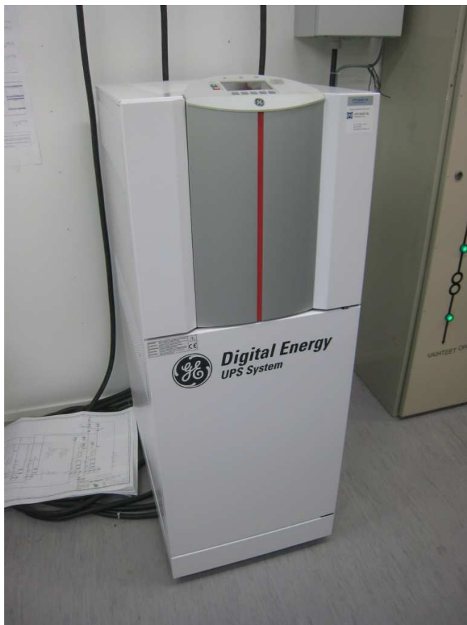
KUVA 10. GE digital energy LP10-33 UPS-laite (Jani Rissanen 2013.)
