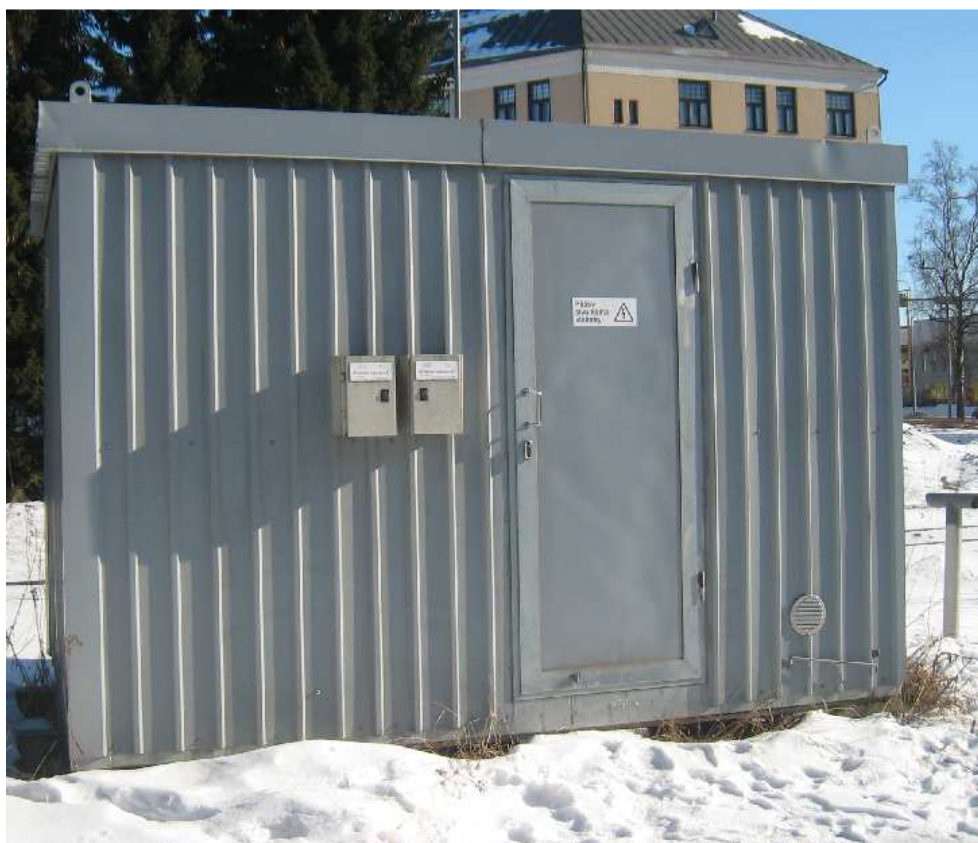
KUVA 11. Varoituslaitoksen laitetila (koju), joka sijaitsee ylikäytävän läheisyydessä (Jani Rissanen 2013.)
