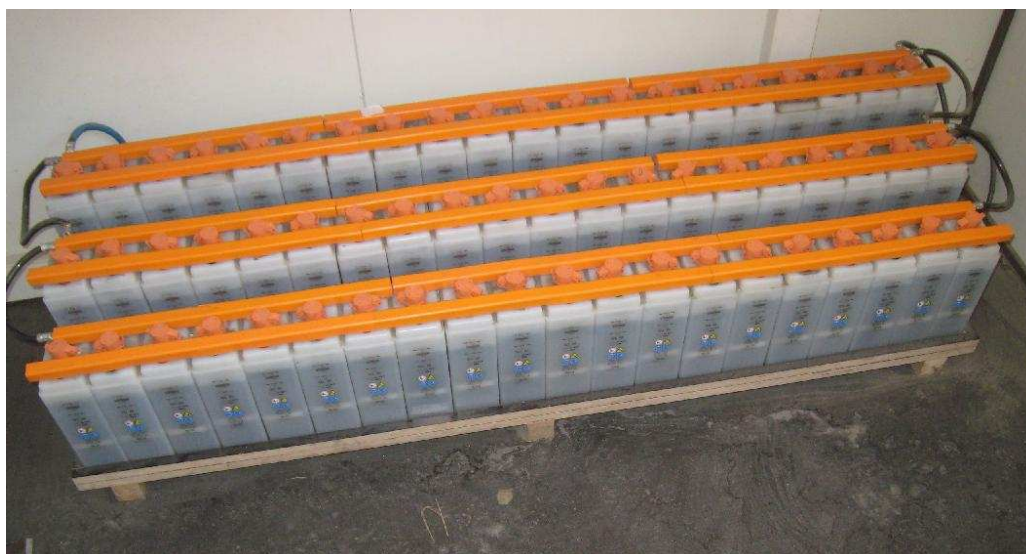
KUVA 12. Pietarsaaren koulukadun varoituslaitoksen NiCd-akusto (Jani Rissanen 2013.)
