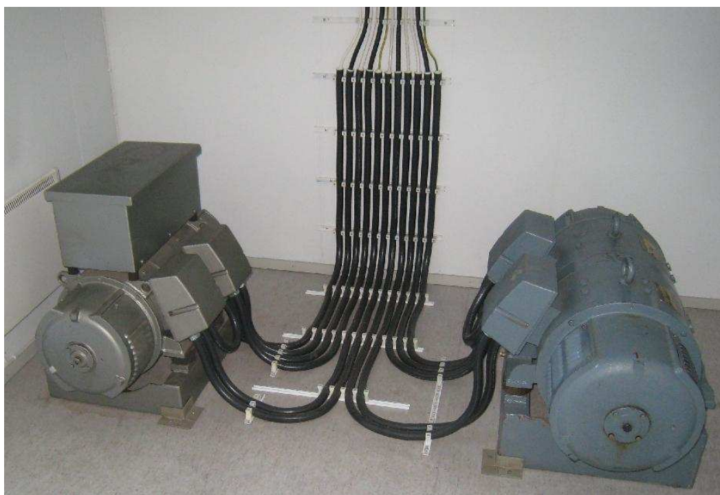
KUVA 8. Asetinlaitteen akuston syöttämät jännitemuuttajat (Jani Rissanen 2013.)
