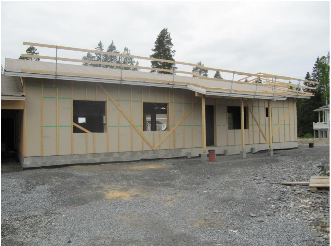
Kuva 5 Oppilaitoksen oma harjoitustyökohde runkovaiheen töiden loppuvaiheessa
