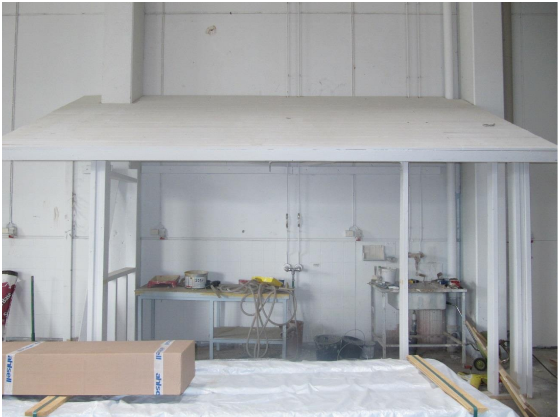
Kuva 4 Harjoituslippa reunakaiteiden asennusharjoittelua varten
