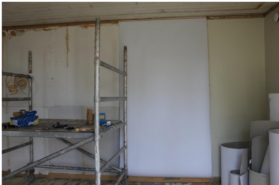
Kuva 4 Ensimmäisen vuodan kiinnittäminen. Kuvassa asentaminen on aloitettu palomuurin vierestä.
