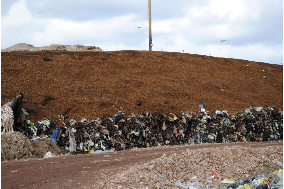
KUVIO 7. Biosuodinkerroksella peitettyä jätettä Mustankorkean uudella jätetäyttö-alueella
