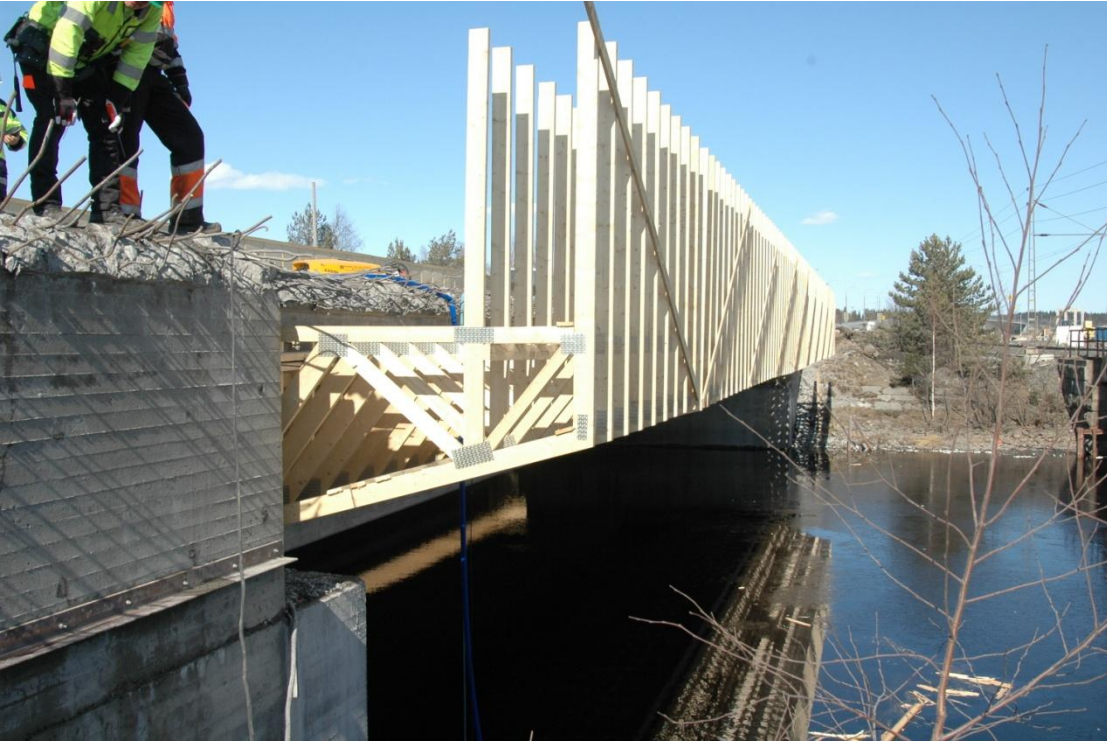
Kuva 16 Asennetut muottiristikot, sillan maatuki ja tuennassa käytettävä kulmarauta (Eetu Lappalainen 2013)
