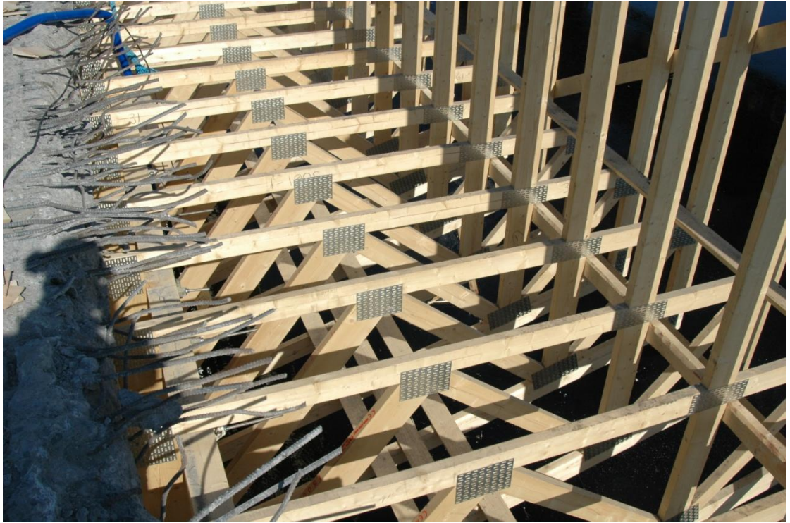
Kuva 14 Paikalleen asennettuja muottiristikoita (Eetu Lappalainen 2013)
