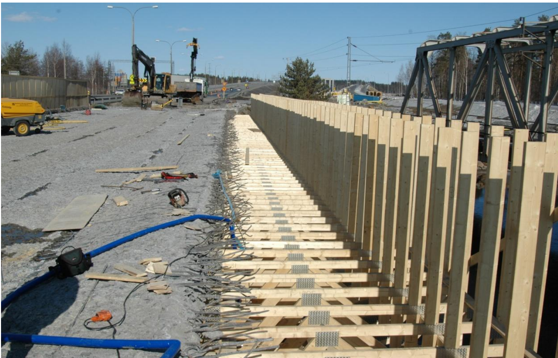
Kuva 13 Paikalleen asennetut muottiristikot (Eetu Lappalainen 2013)
