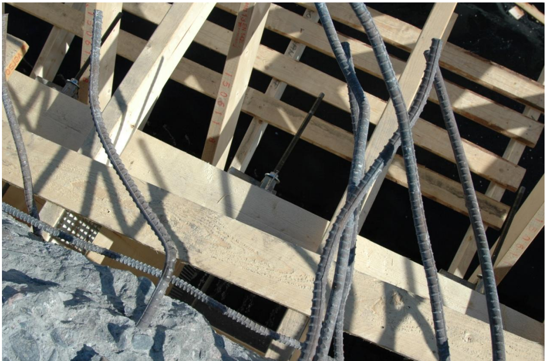
Kuva 15 Kotelopalkkiin ankkuroitu kierretanko (Eetu Lappalainen 2013)
