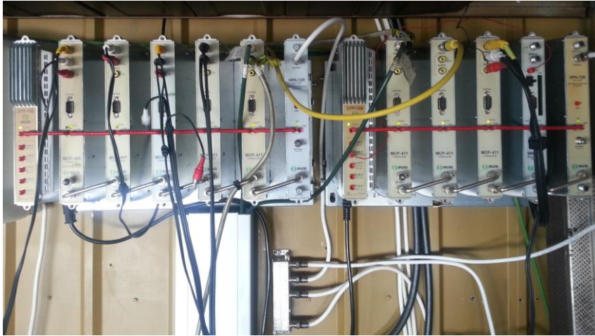
Kuva 37. Vermoon asennetut RF-modulaattorit.
