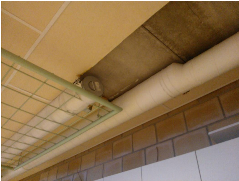
Kuva 12. Automaatiolaboratorion tulpattu kanavisto
