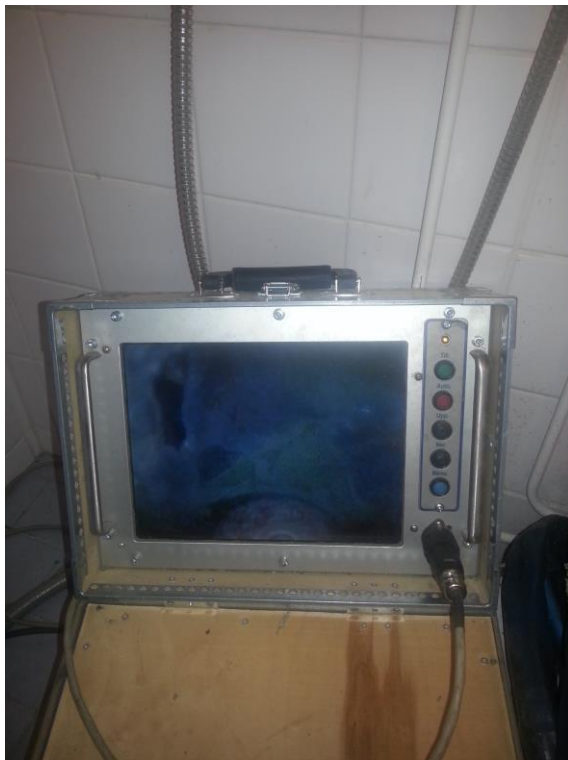
KUVA 2. Puhdistetun linjan kuvausdokumentointi käynnissä
