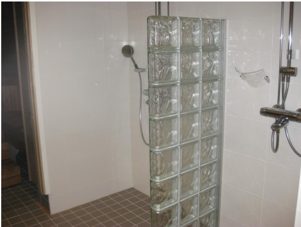
KUVA 12. Kiinteistön saunaosaston pesuhuone saneerauksen jälkeen
