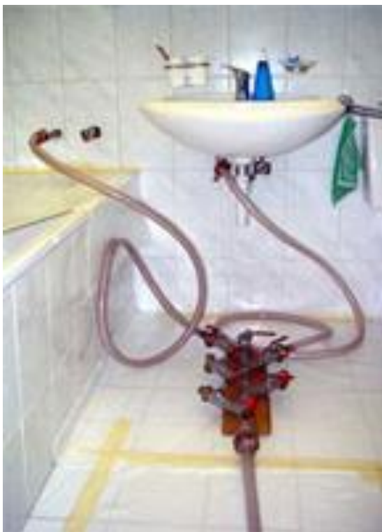
KUVA 7. Käyttövesijohdon pinnoitus (Poxytec Oy 2013).
