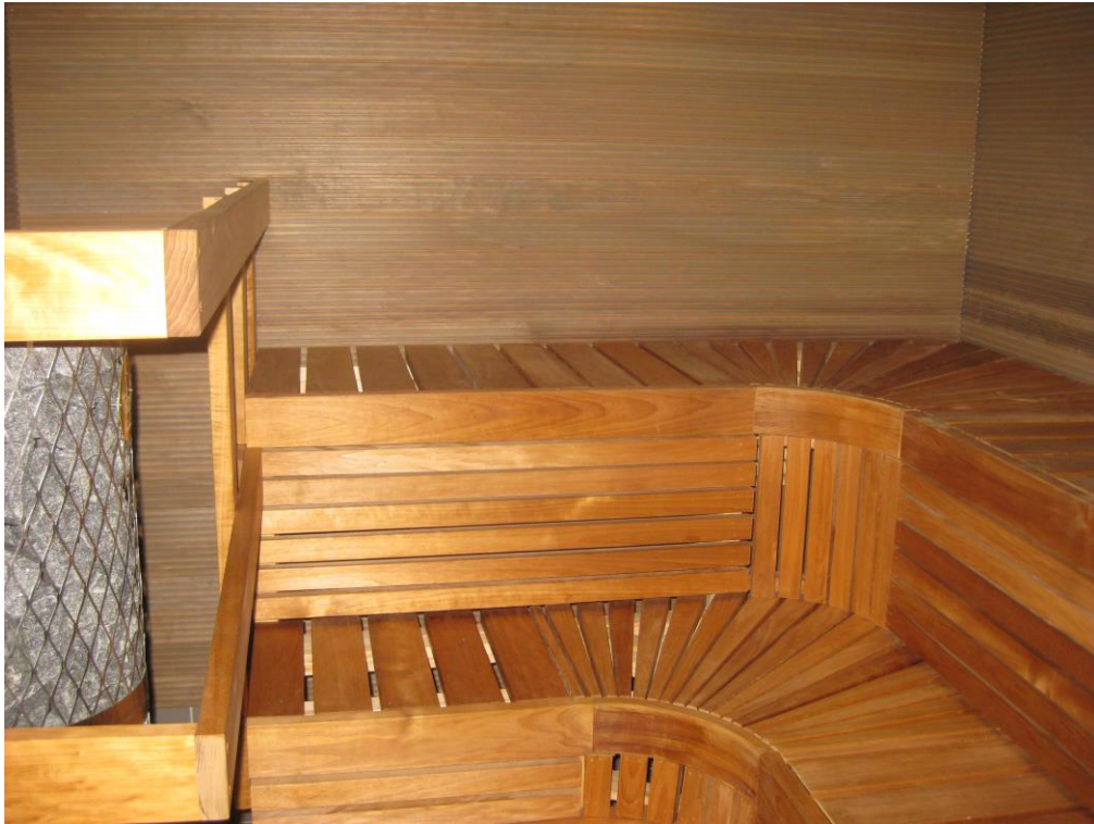
KUVA 11. Kiinteistön saunaosasto saneerauksen jälkeen
