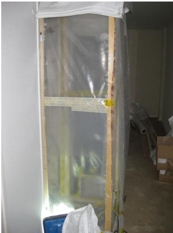
KUVA 10. Märkätilan purku vaatii suojaukset ja alipaineistuksen
