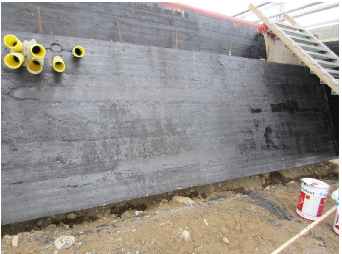
Kuva 4 Maanvastaisten pintojen bitumisivelyt on käynnissä.
