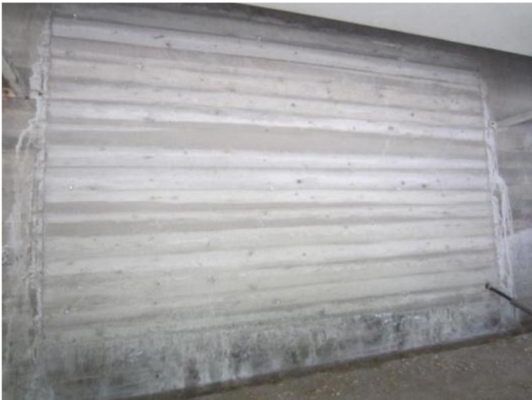
Kuva 5 Puretun laitetilän aukko on valettu umpeen.
