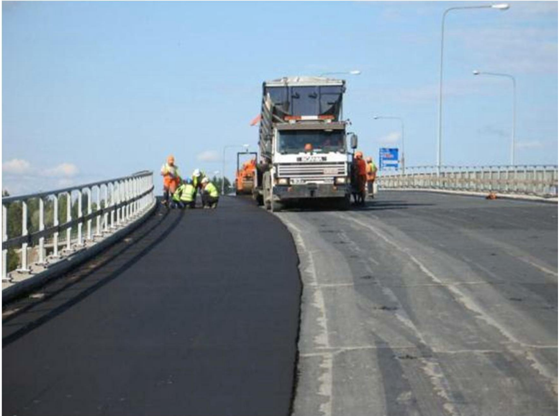
Kuva 21. Suoja-asfaltin levitystä Pekkalan sillalla. Valokuva Marko Savolainen 2011.
