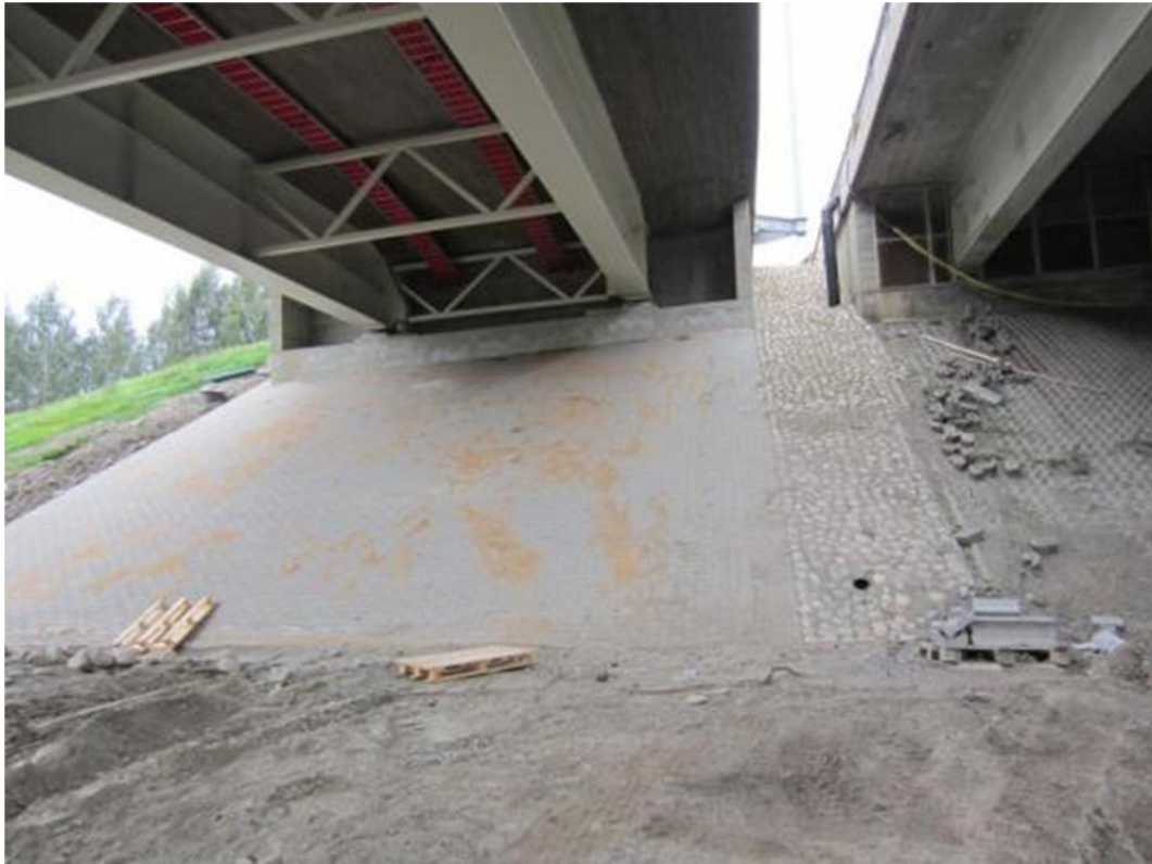
Kuva 8 Etuluisikan betonikiviverhous ja väliosan hieno kenttäkiviverhous.
