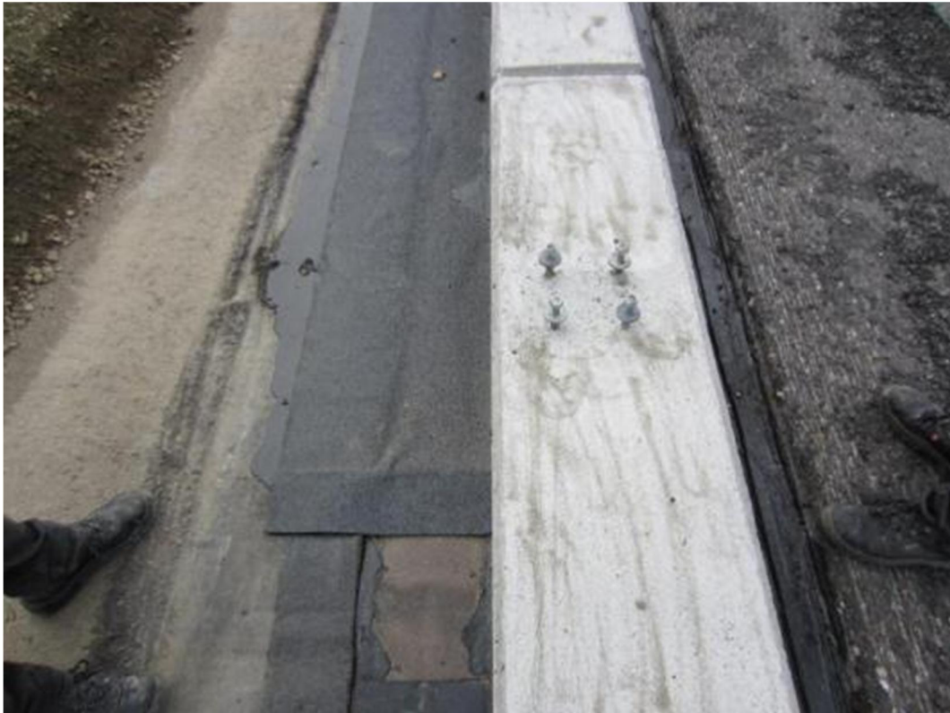
Kuva 4 Vesieristys välikaiteen vieressä (2x aluskermi, 1x pintakermi).
