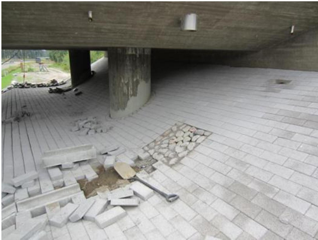
Kuva 2 Hulevesikourun asennus kesken.
