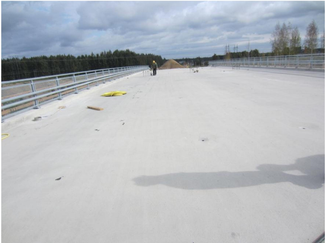
Kuva 1 Kansilaatan tasainen yläpinta.
