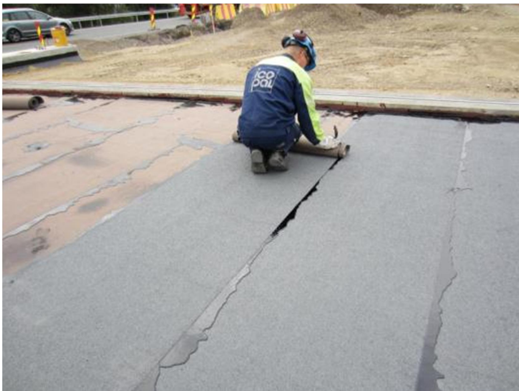
Kuva 1 Pintakermin asennus käynnissä.
