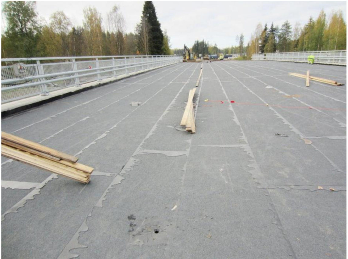
Kuva 1 Hyvin liimattua ja porrastettua pintakermiä.
