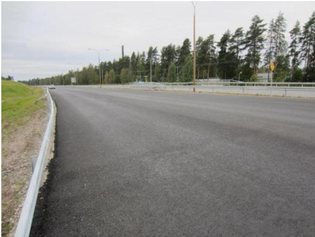
Kuva 18 Molemmat siltapuoliskot liikenteellä.
