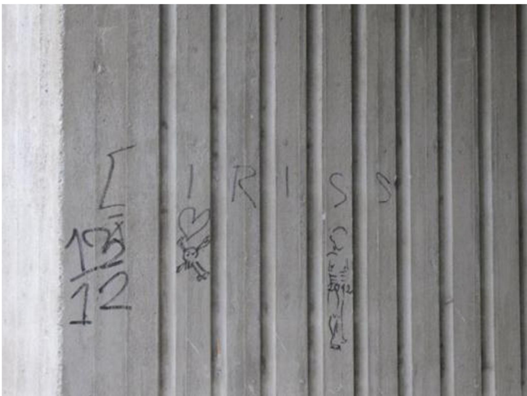
Kuva 21 Töherrettyä etumuuria.
