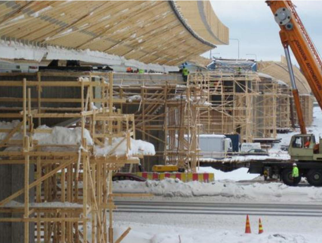
Kuva 18. Pekkanen sillan siirto käynnissä. Valokuva Marko Savolainen 2011.
