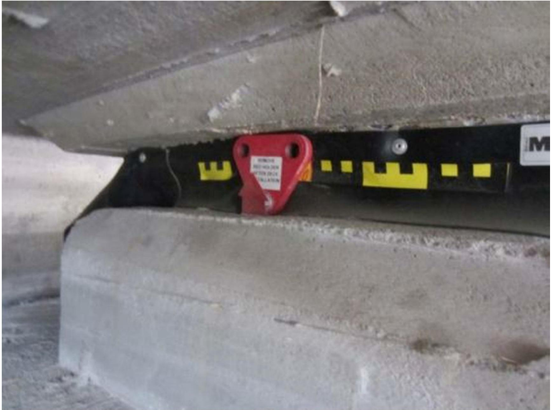
Kuva 26. Laakerin lukituslevy on jäänyt poistamatta, jolloin mitta-asteikon lukeminen ei onnistu. Valokuva Marko Savolainen 2012.
