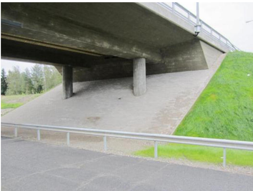
Kuva 23 Hyvin siltaan istuva verhoilu.
