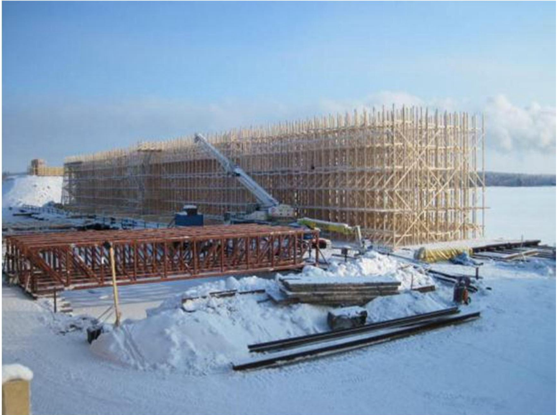
Kuva 1. Tikkalansaaren rinnakkaistien sillan tukitelineen asennusta. Valokuva Marko Savolainen 2011.
