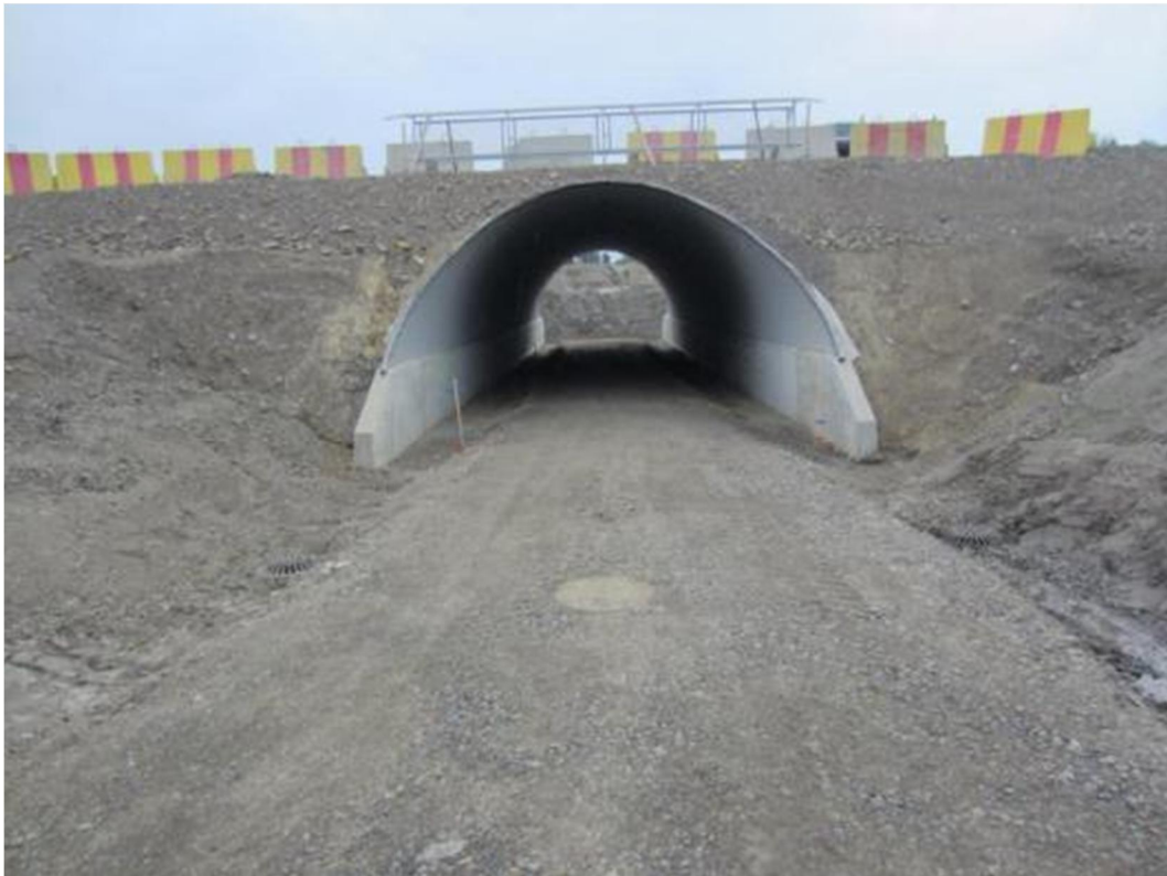
Kuva 12 Kevyen liikenteen väylän rakennekerrosten teko käynnissä.
