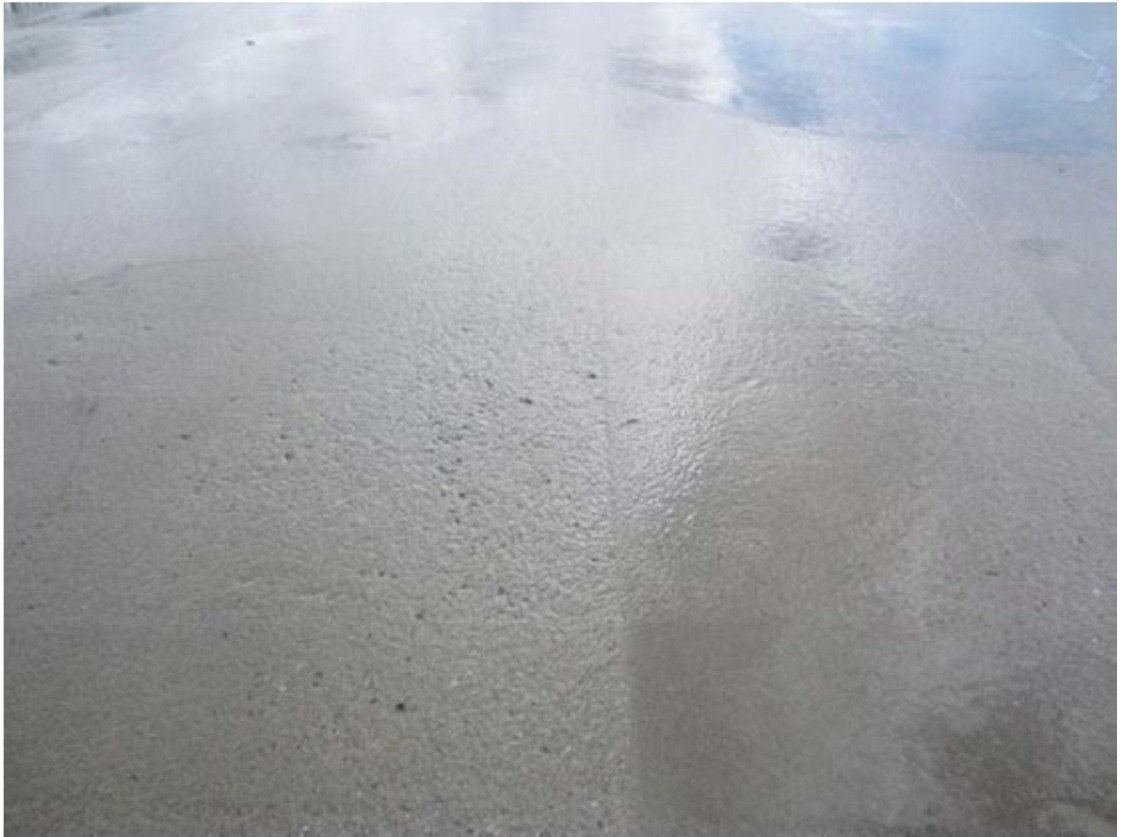
Kuva 12. Normaali puhdistusaste (SILKO 1.203). Valokuva Marko Savolainen 2012.
