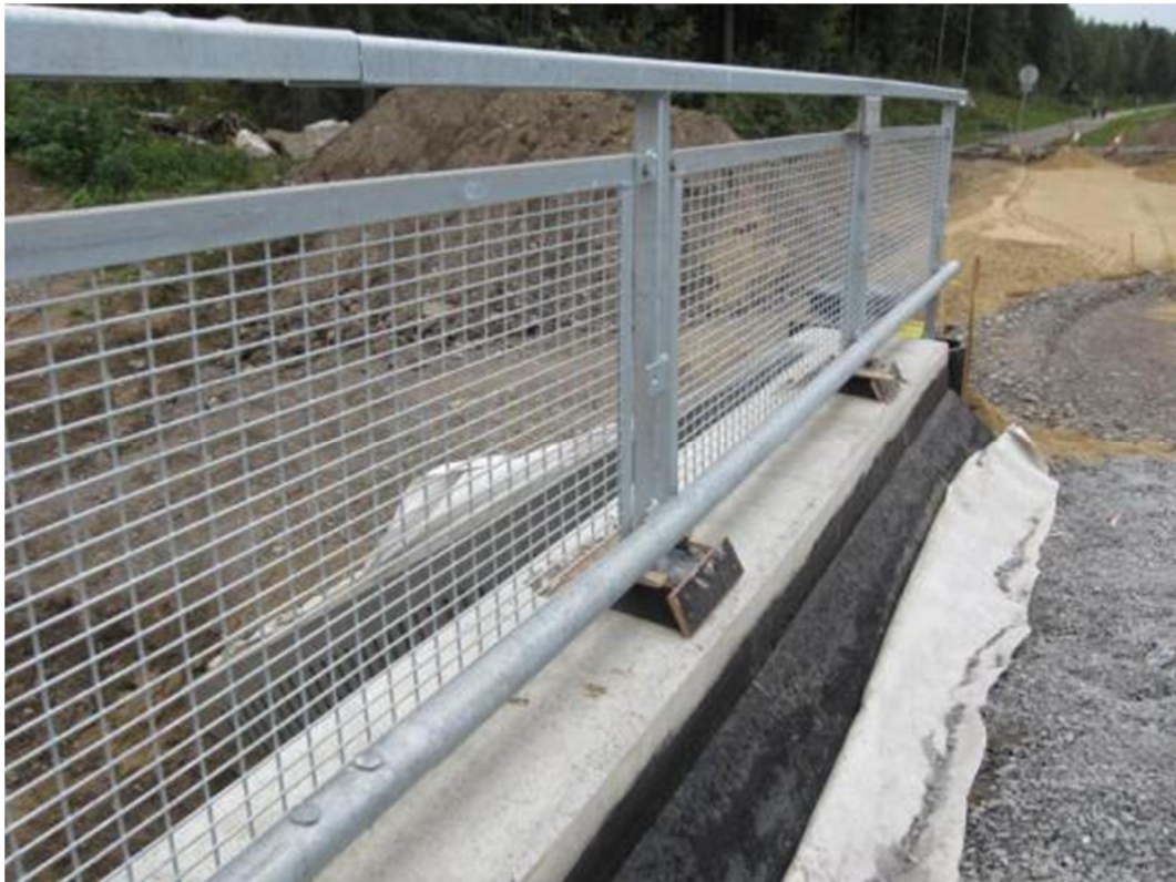
Kuva 9 Kaiteen juurivalut on tehty.
