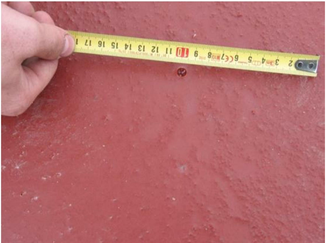
Kuva 14. Suuri huokonen epoksiivistyksessä. Valokuva Marko savolainen 2011.
