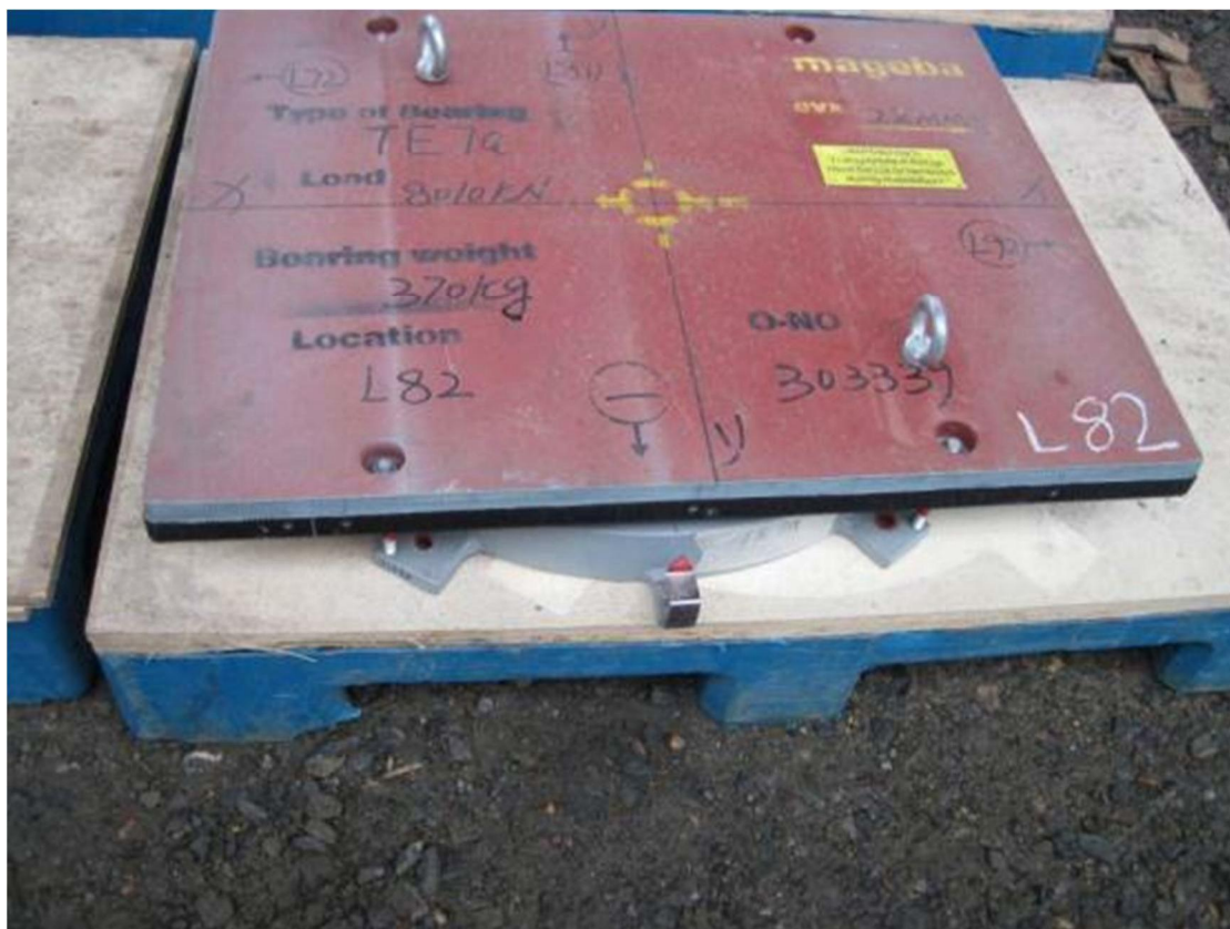
Kuva 25. Merkinnät laakerilevyssä. Valokuva Marko Savolainen 2011.
