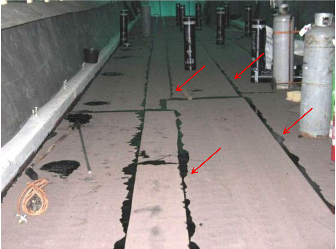
Kuva 15. Aluskermin saumat on asennettu väärin ns. vastakarviin. Valokuva Marko Savolainen 2011.
