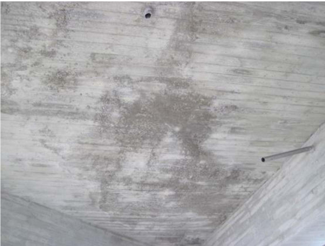
Kuva 7. Värivaihtelua Vuorelan eteläisen risteyssillan kannessa. Valokuva Marko Savolainen 2011.
