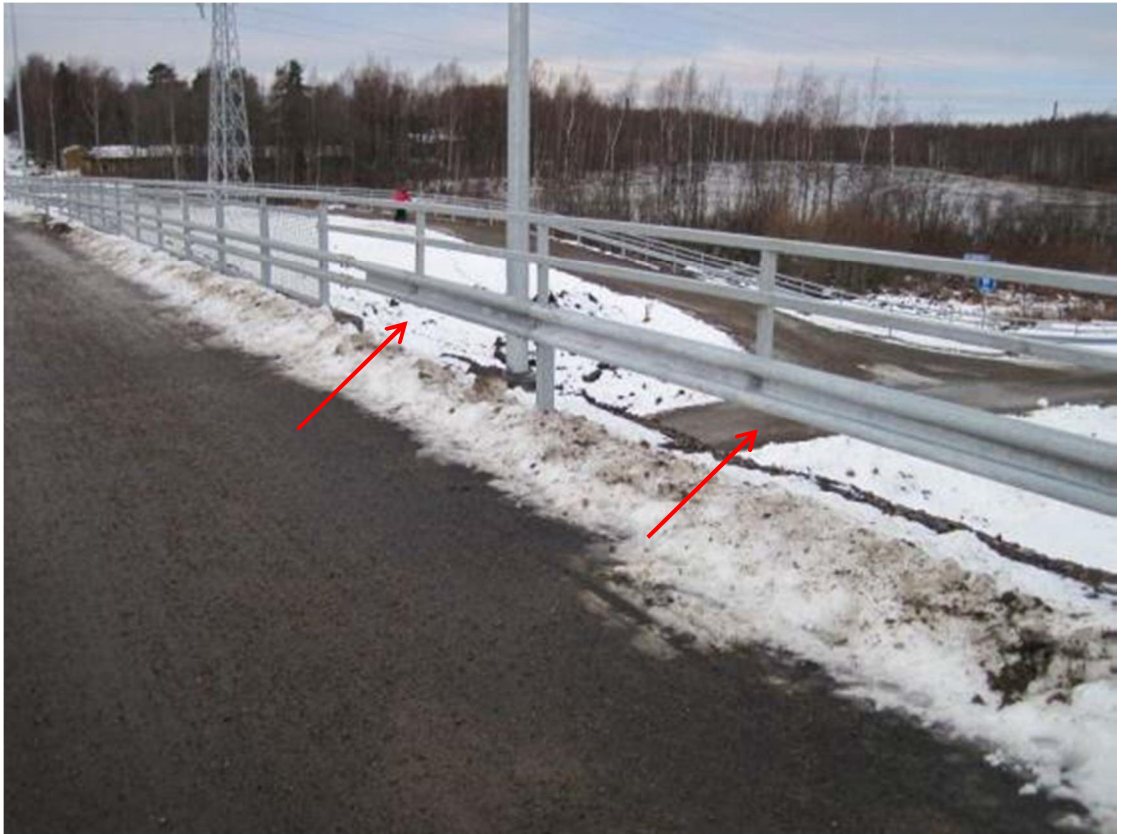
Kuva 30. Pengerkaiteen tolpat ovat liian harvassa. Valokuva Marko Savolainen 2012.
