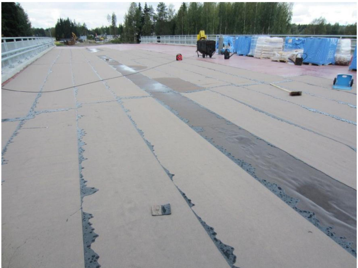
Kuva 2 Kermit on asennettu tasaisesti.
