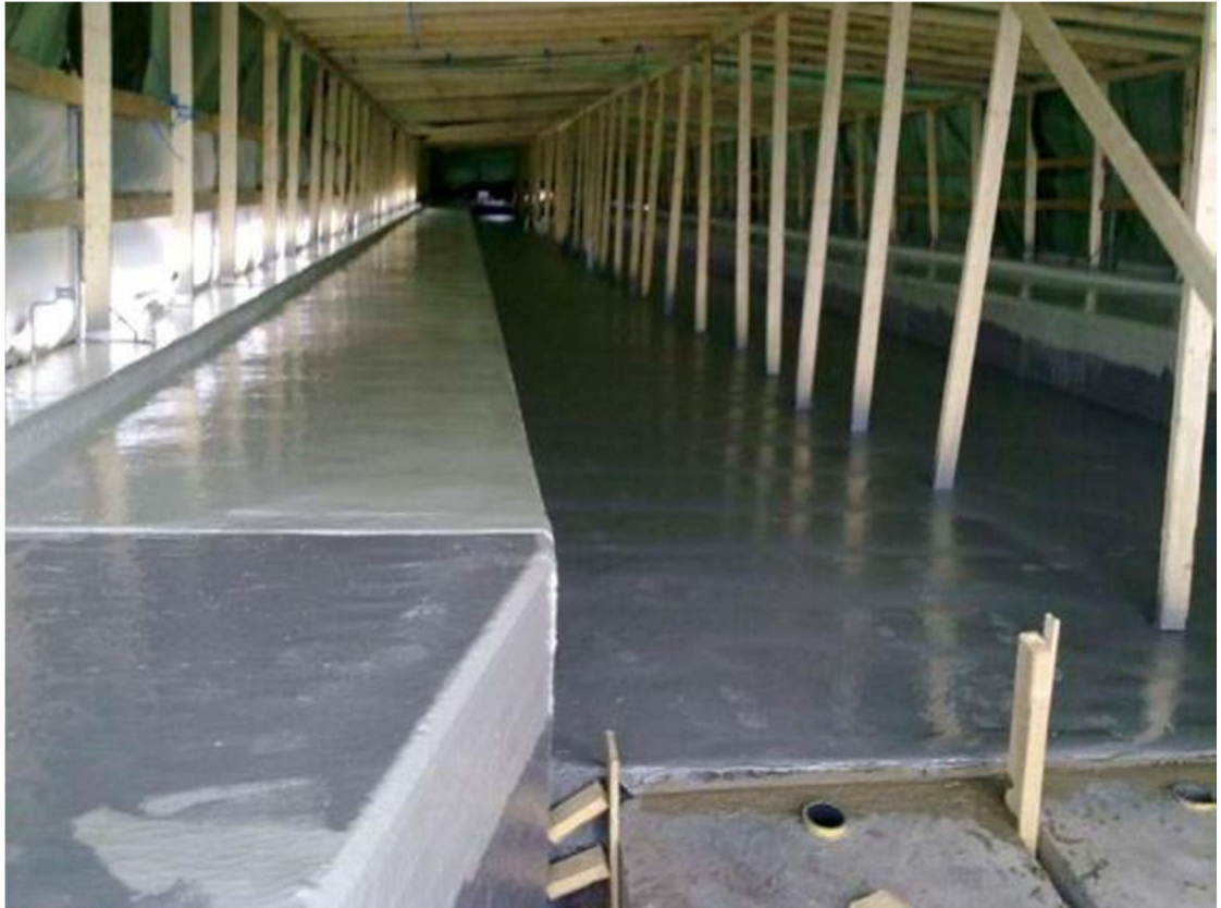
Kuva 17. Tikkalansaaren ratasillan polyuretaanieristys. Valokuva Marko Savolainen 2011.
