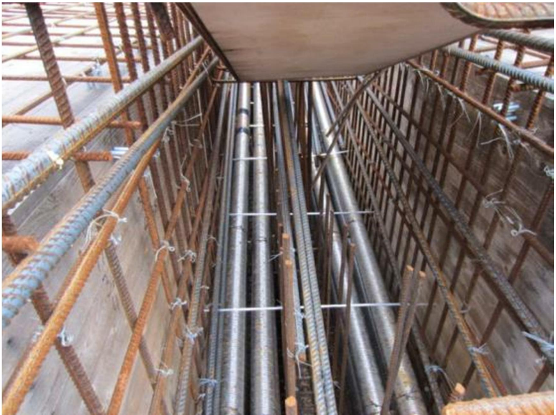
Kuva 3. Tikkalansaaren läntisen sillan jännekaapeliin suojausputket väliankkurimuotin alapuolella. Valokuva Marko Savolainen 2012.
