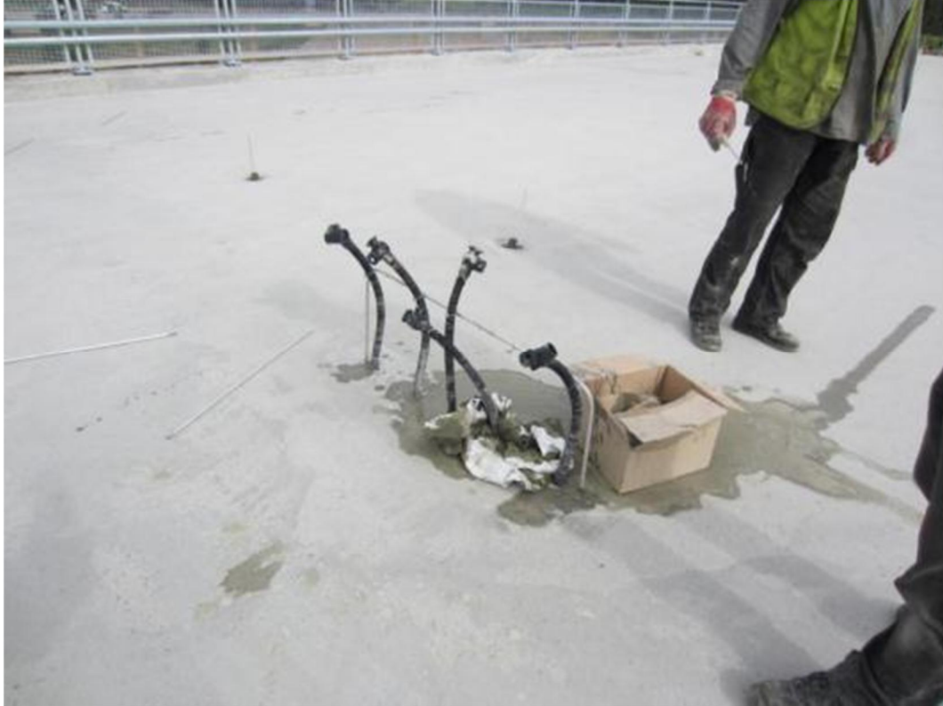
Kuva 10 Injektointimassa on saavuttanut välituen T2 kohdan.
