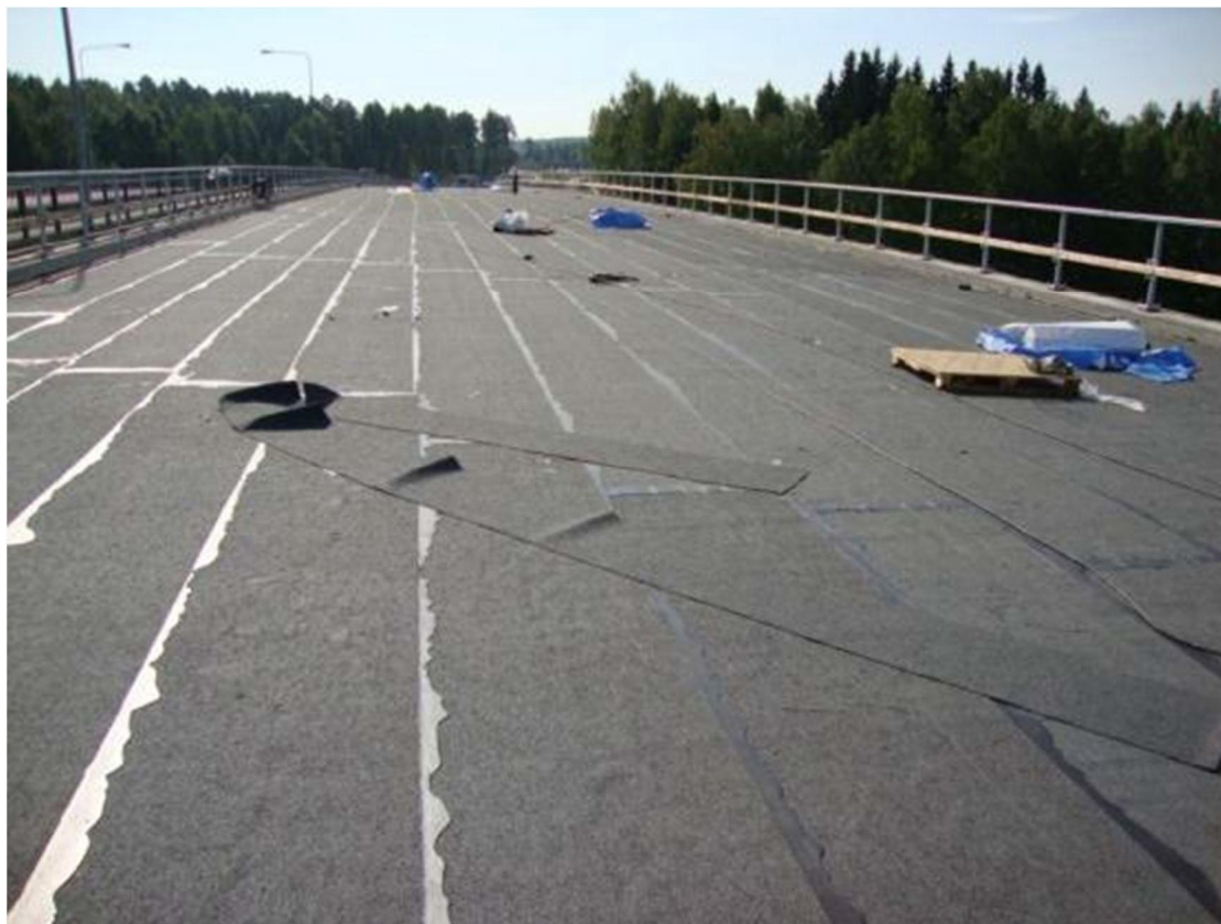
Kuva 16. Pintakermin hyvää asennusjälkeä Pekkalan sillalla. Valokuva Marko Savolainen 2011.
