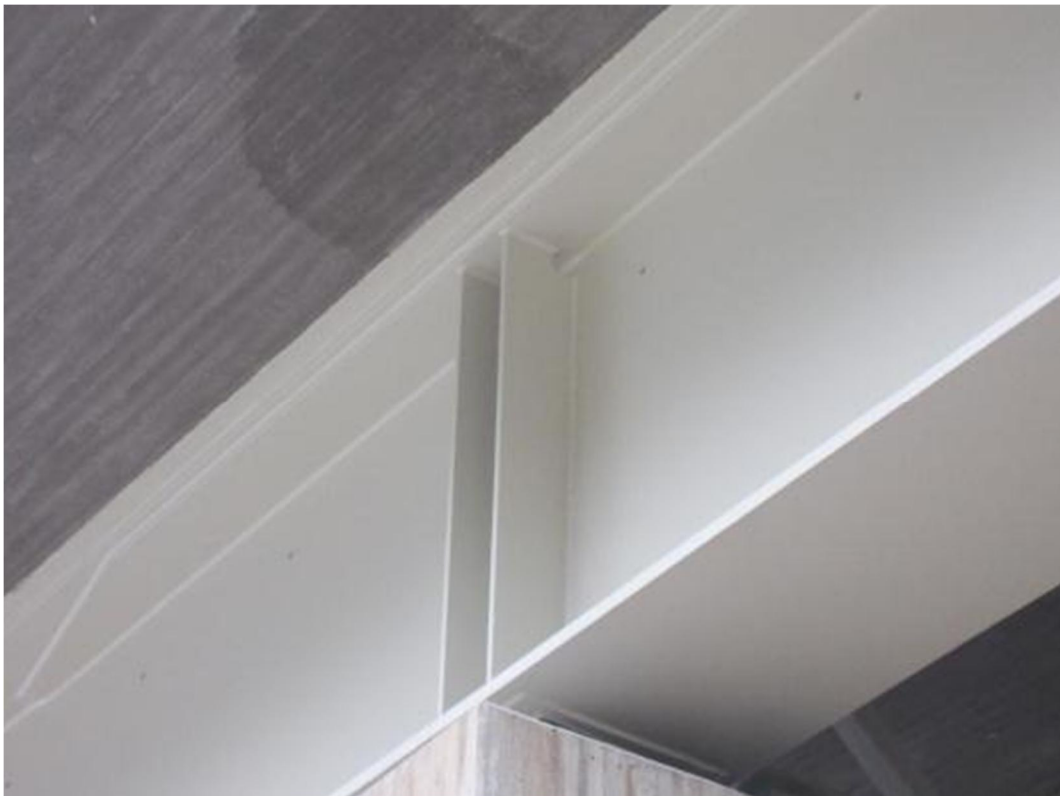
Kuva 7 Palkiston maalaustyöt on saatu päätökseen.
