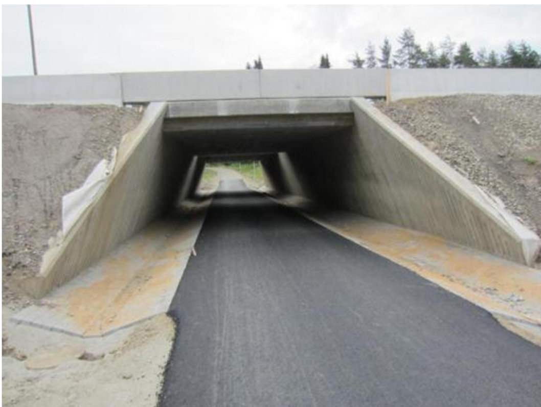
Kuva 17 Kevyen liikenteen väylä on päällystetty ja sivuojat verhoiltu.
