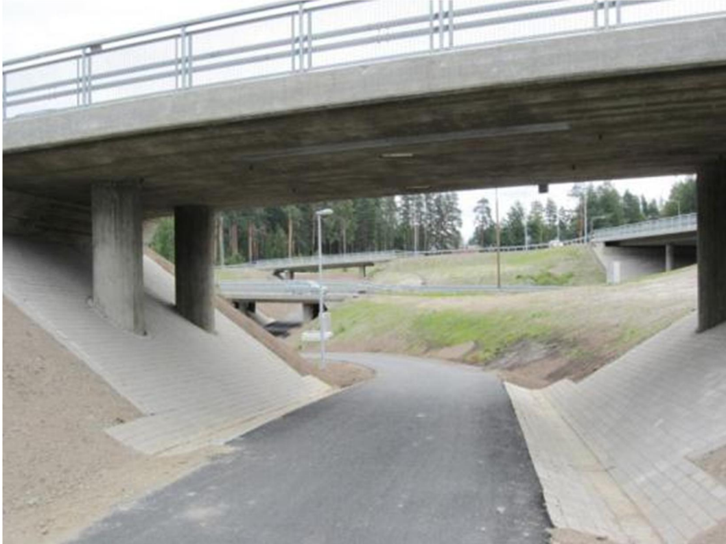
Kuva 24 Näkymä silloille S36 kohdalta.
