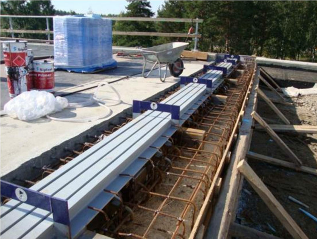
Kuva 27. Pekkalan sillan monielementtinen liikuntasaumalaite. Valokuva Marko Savolainen 2011.
