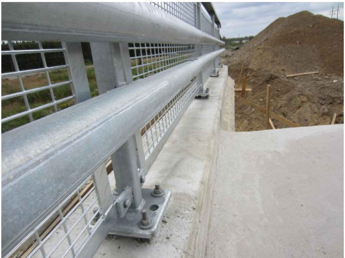
Kuva 2 Reunapalkin vierustan vastakallistus.
