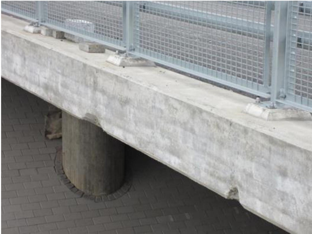
Kuva 16 Reunapalkin harvavalukohdat on piikattu.
