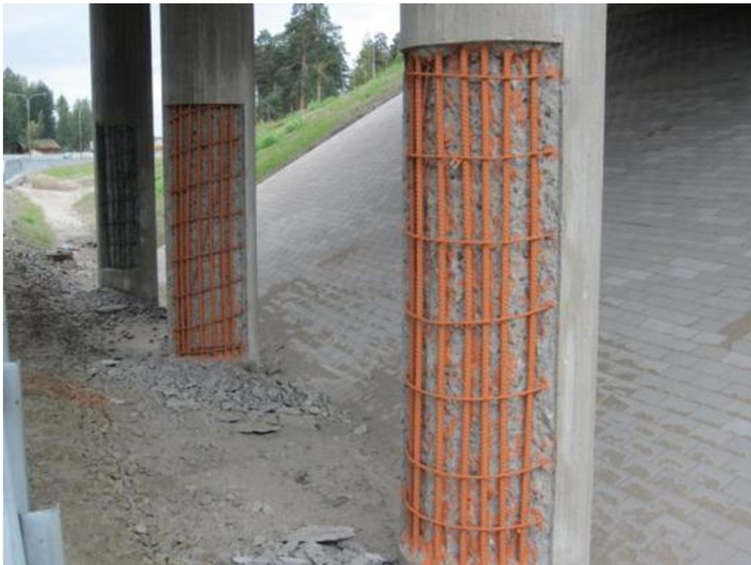
Kuva 15 Pilariraudotteiden ruostesuojaus käynnissä.
