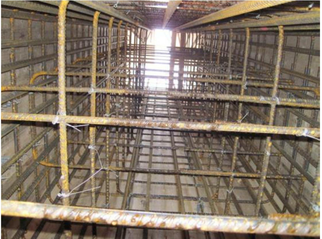
Kuva 5. Massiivipilarin raudoitusta. Valokuva Marko Savolainen 2011.
