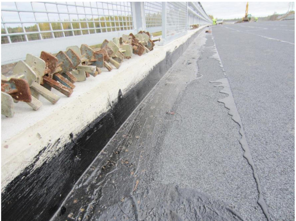
Kuva 2 Reunapalkin sisäpinnan ja kermin reunan kumibitumisively.
