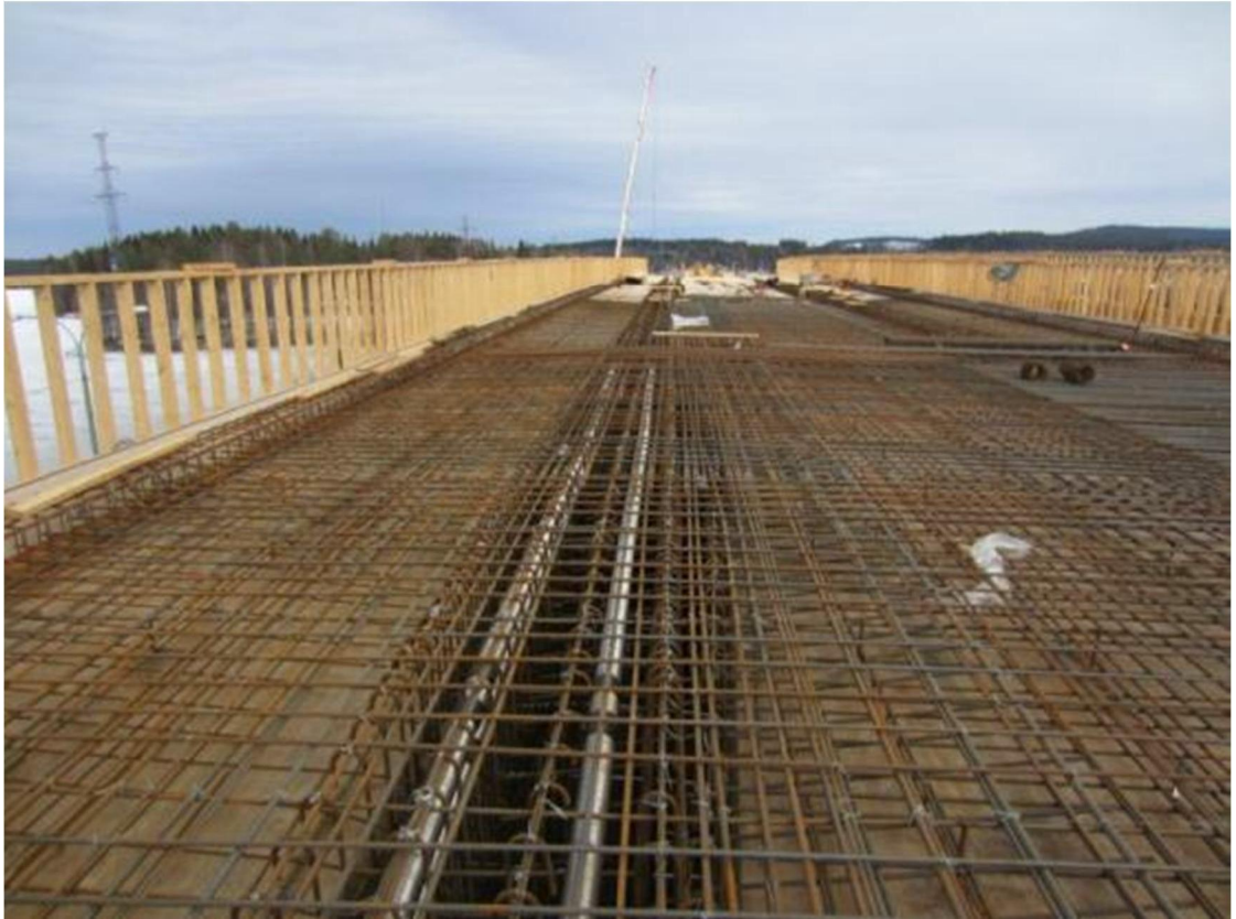
Kuva 2. Tikkalansaaren läntisen sillan kannen raudoitusta. Valokuva Marko Savolainen 2012.
