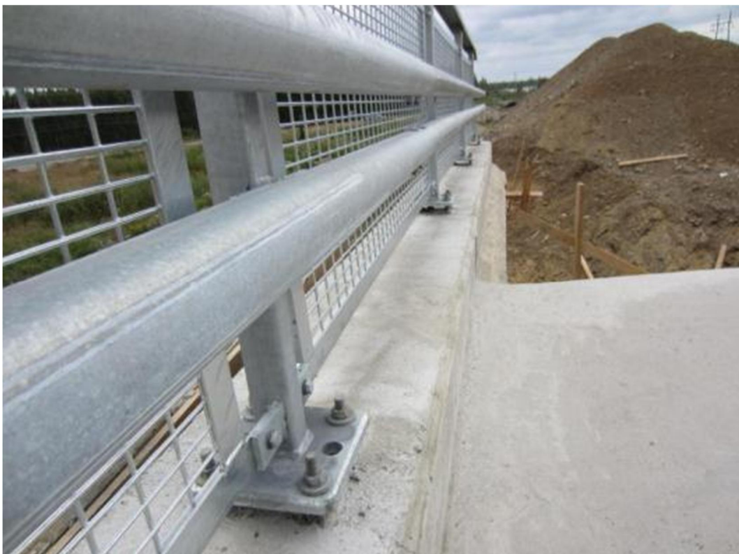
Kuva 11 Siipimuurin pääty ei ole aivan linjassa.
