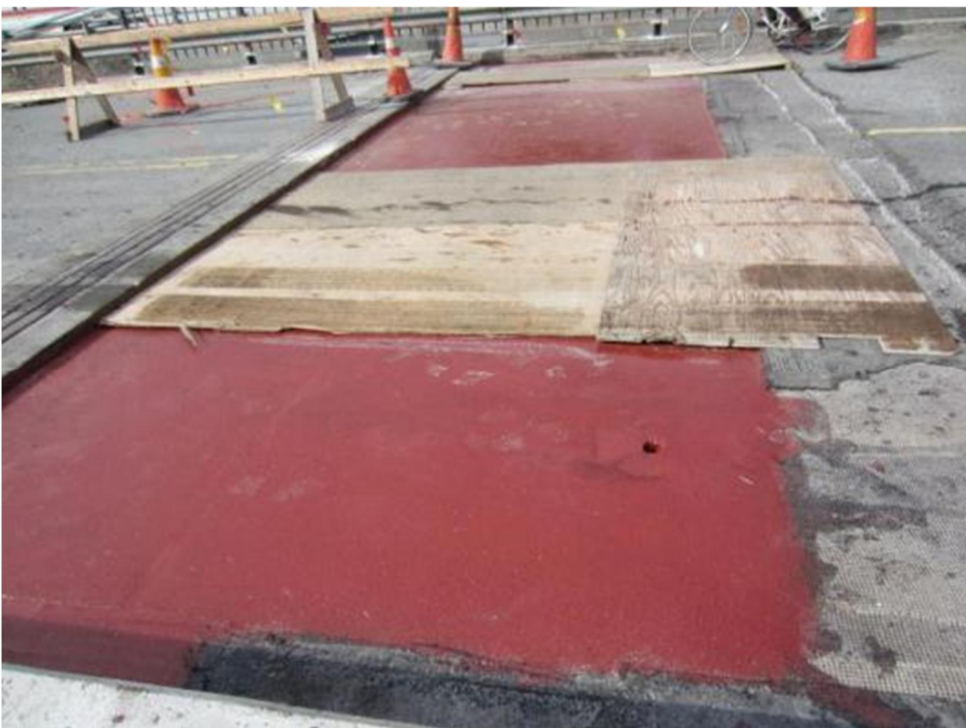
Kuva 3 Kannen yläpinnan kunnostusta tuella T9.
