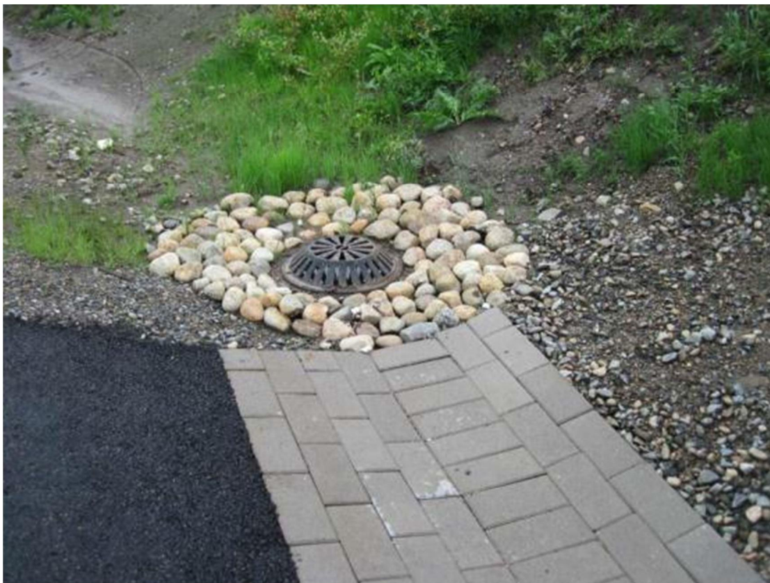
Kuva 31. Hyvin tehty kuivatuslaite sulautuu myös ympäristöön. Valokuva Marko Savolainen 2012.
