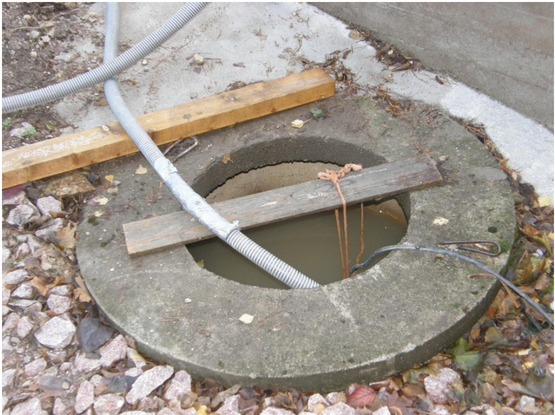
KUVIO 8. Suojaamaton kaksi metriä syvä sadevesikaivo
