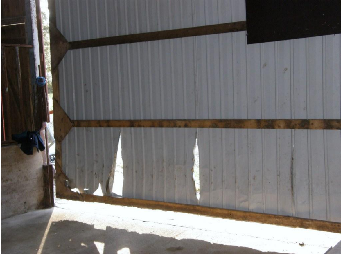
KUVIO 5. Rikki mennyt navetan liukuovi on vaarallinen
