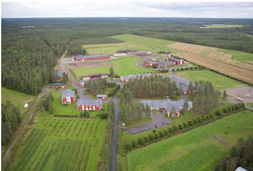
Kuvio 1. Ilmakuva Perhon yksiköstä. Keski-Pohjanmaan maaseutuopiston Perhon yksikön rakennuksia ja oppimisympäristö.
