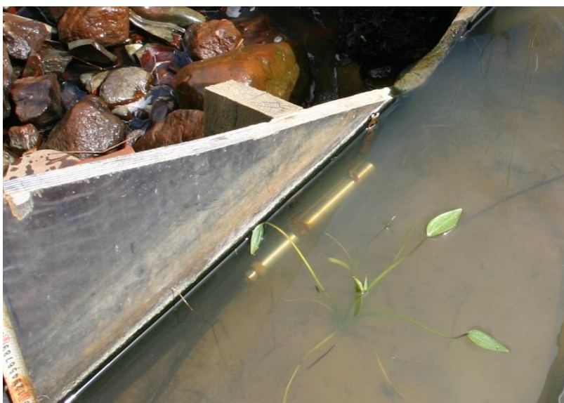
Kuva 9. Keller DCX 22 paineanturi asennettuna pilottikohteessa
