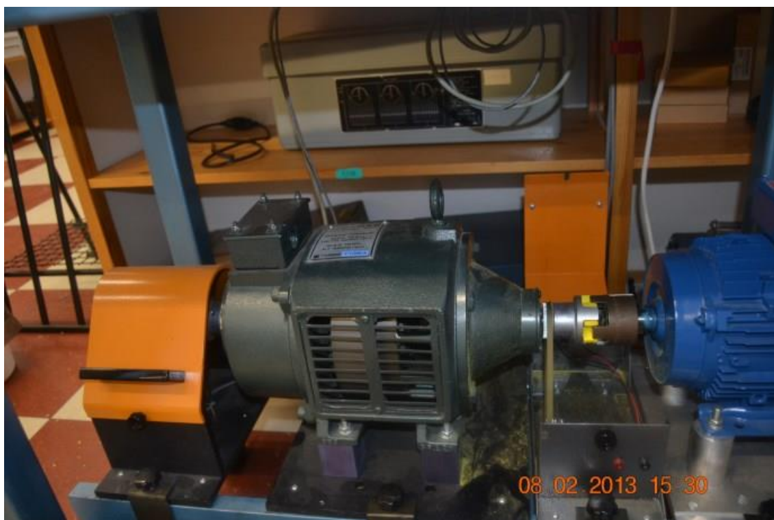
Kuva 24. Turvallinen nivelakselin suojaus
