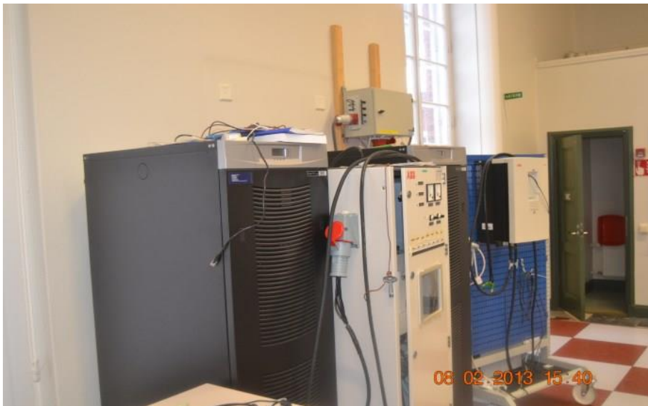
Kuva 30. UPS-laitteistot
