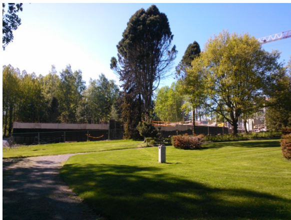
KUVA 1. Rakennustyömaa. Gösta kasvaa.
