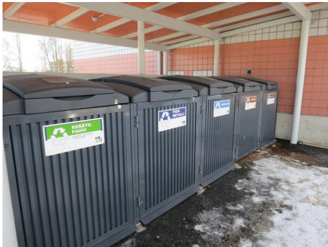
Kuva 10. Matarankatu 6:n jätekatoksen toinen puoli.
