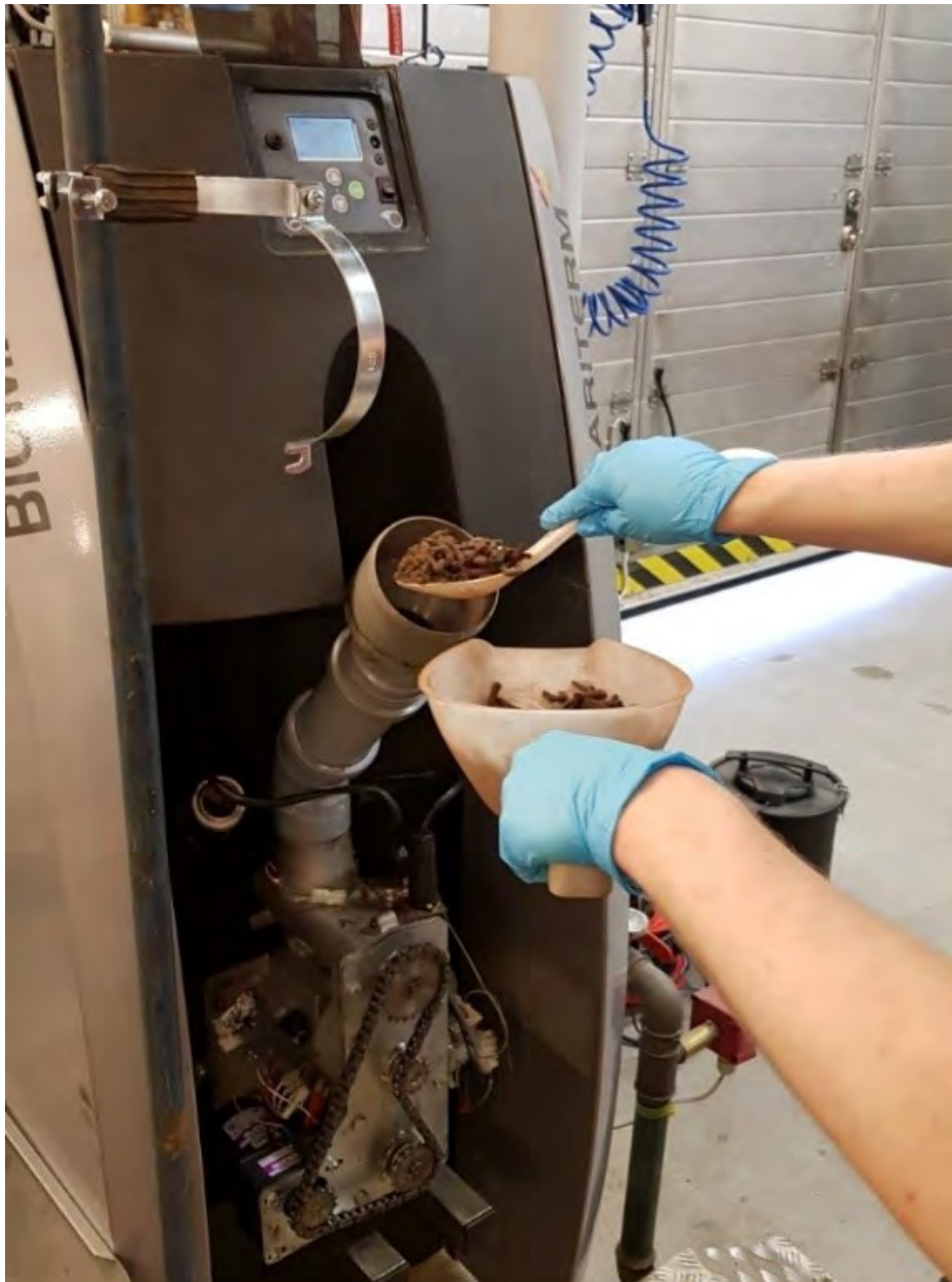
KUVA 3. Lietteiden syöttö annosteluruuviin (kuva Salla Pulliainen).
