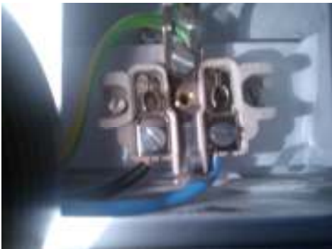
Kuva 2. Maadoitettu pistorasia vessassa
