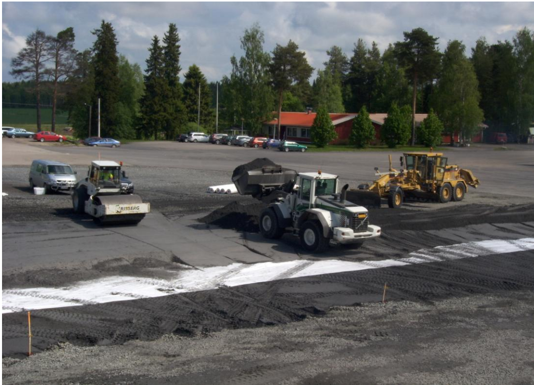
Kuva 6. Koekenttäalueen B tiivistäminen.
