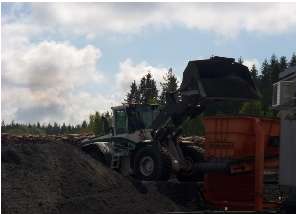
Kuva 4. Pyöräkuormaaja syöttää tuhkaa asemasekoittimeen.
