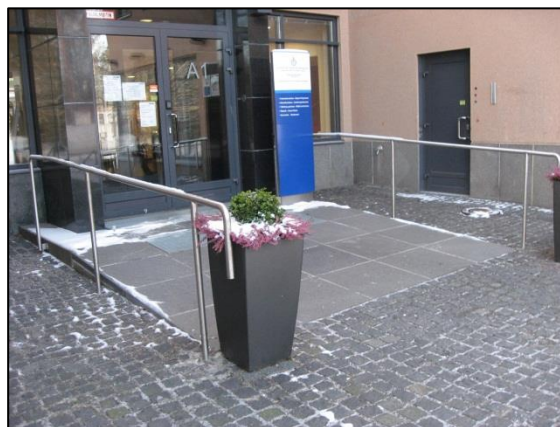
Kuva 7. Vasemmalla kynnysluiska, oikealla sisäänkäynnin askelma korvattu luiskalla
