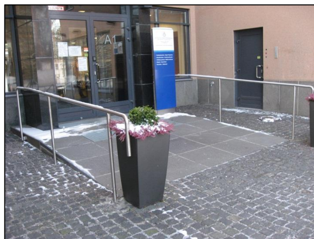
Kuva 14. Sisäänkäynnin luiska, jossa käsijohteet molemmilla puolilla ja ne jatkuvat luiskan yli
