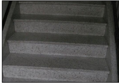
Kuva 10. Portaat, joissa ulkoneva reuna
