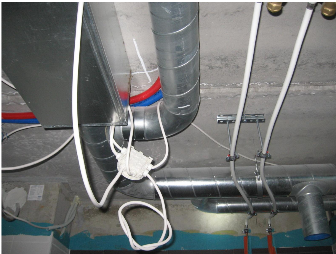
Kuva 6. LVIS-työt vaikuttavat merkittävästi työmaan onnistumiseen.
