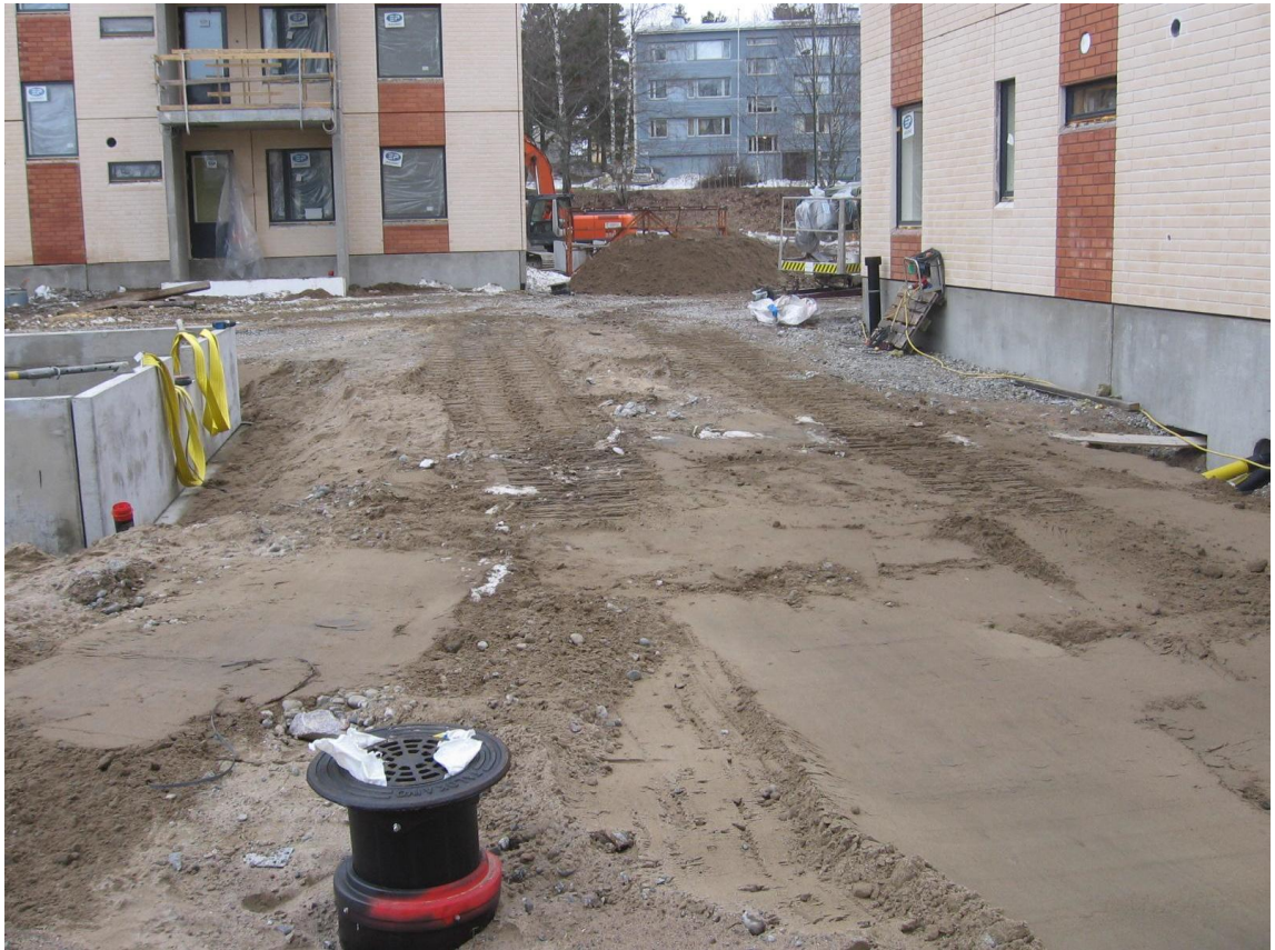
Kuva 9. Maanrakennustyöt antavat suunnan työmaan onnistumiselle.
