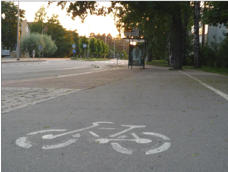
Kuva 6. Erityisesti linja-autosta poistuvan matkustajan turvallisuus paranee, kun pyöräilijät ohjataan pysäkin ohi katoksen takaa
