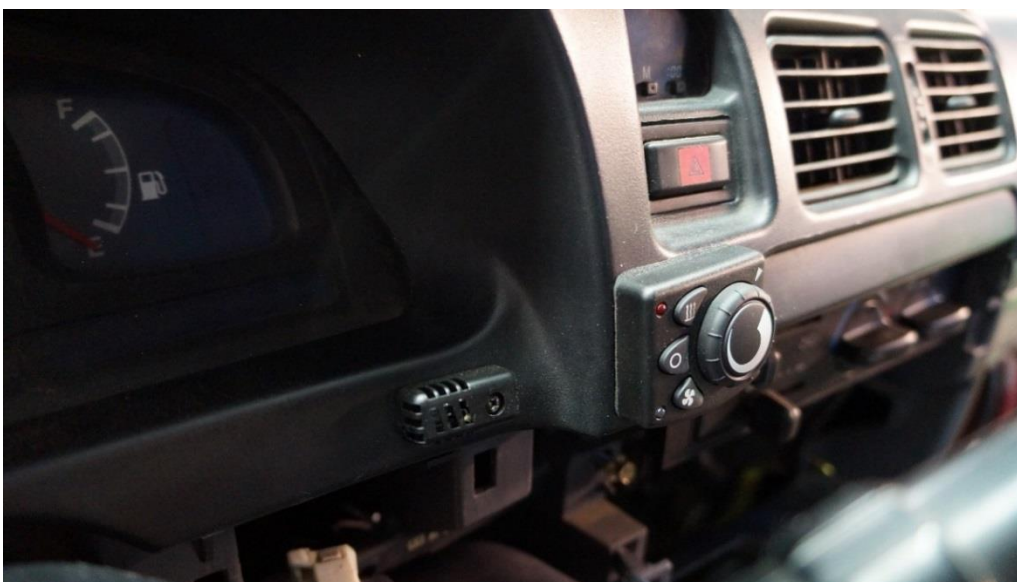
KUVA 10. Säätimen ja sisälämpötilan anturin sijoittelu
