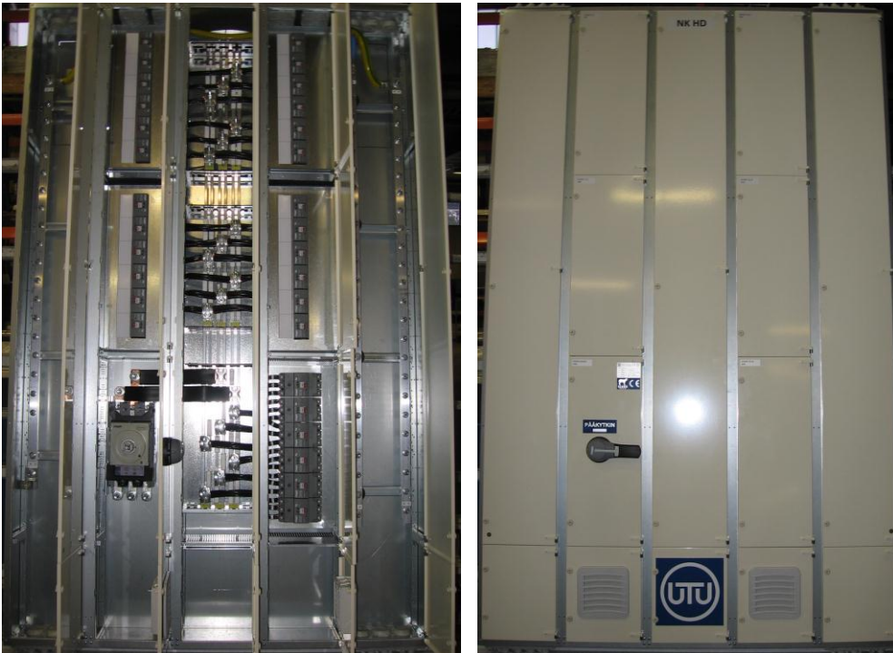
Kuva 4.4. ja 4.5. Keskus viimeistelyvaiheen jälkeen kansitettuna. ILVES-HD
