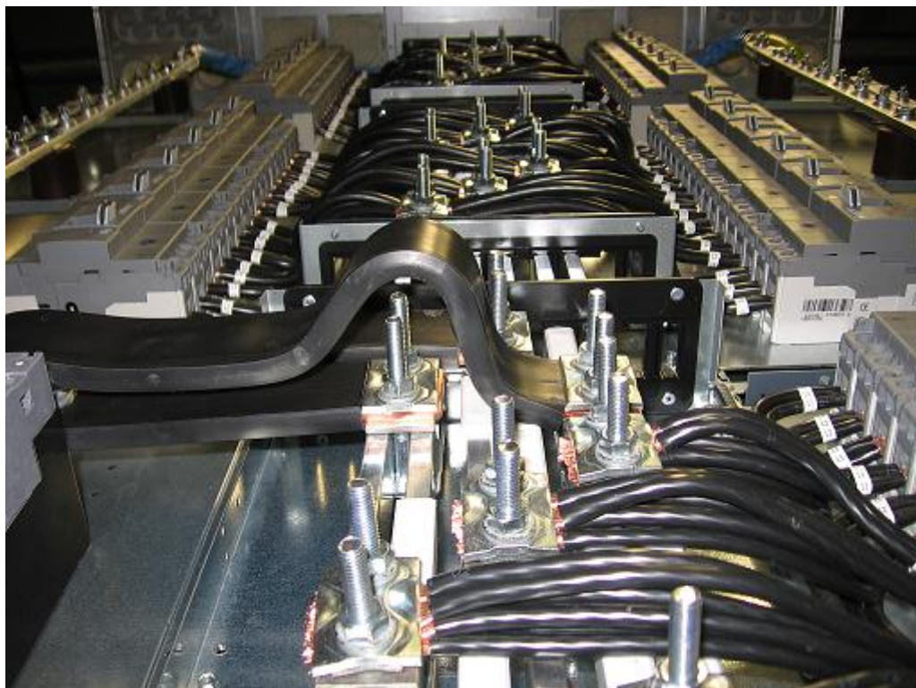
Kuva 6.3. Kuva keskuksesta tarkastusvaiheen jälkeen, ennen kansitusta.
