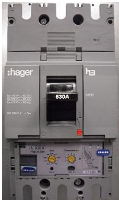
Kuva 5.5. Keskuksen ILVES-HD pääkatkytkin HND630H.
