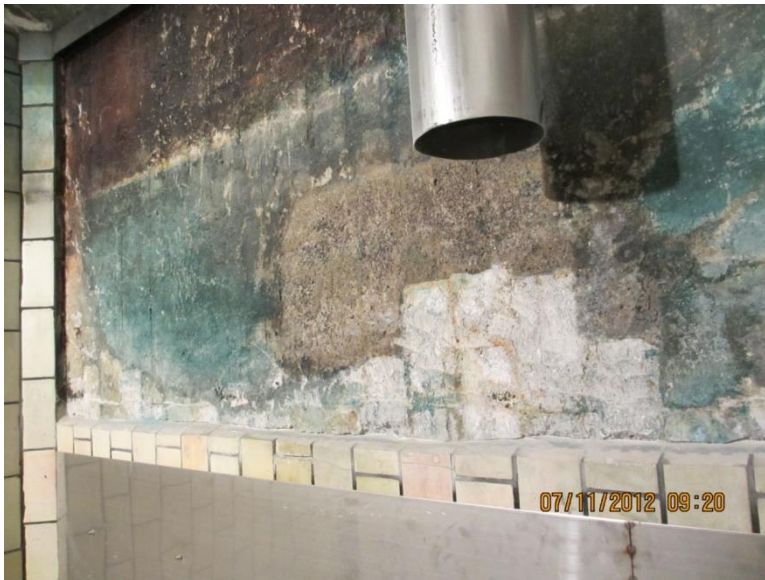
KUVA 3. Takaseinästä poistetut tiilet
