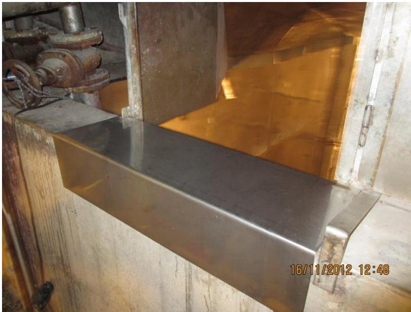
KUVA 12. Yläreunojen tukeminen laadunvarmistamiseksi
