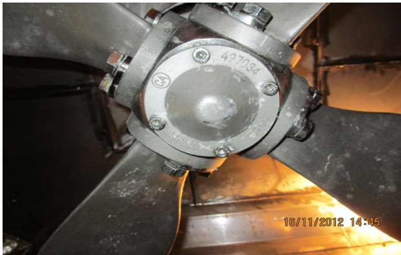
KUVA 4. Lajojen kiinnitys
