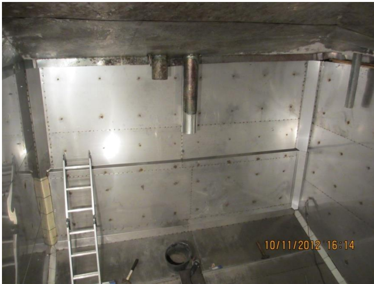
KUVA 10. Levyt tig-hitsauksella, naulauksella ja ankkuroinneilla.
