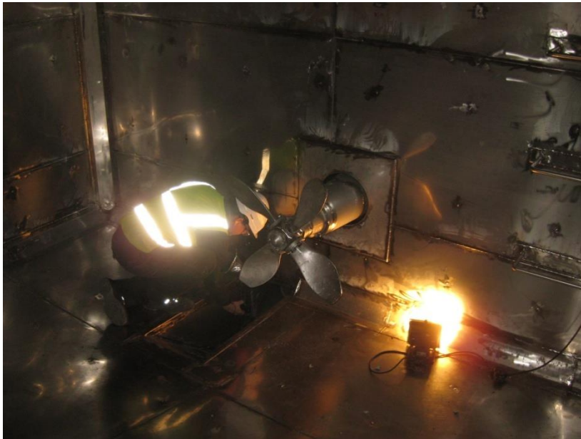
KUVA 11. Valmis säiliö tarkastuksessa
