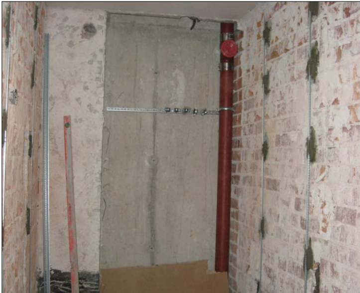
KUVA 1. Kylpyhuoneen purkutyöt (Reijo Venäläinen 2013)
