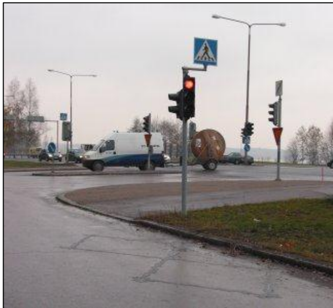
Kuva 7. Pysäytysviivan tuntumassa oleva kahdeksikkoilmaisin, joka toimii läsnäoloilmaisimena (9.)
