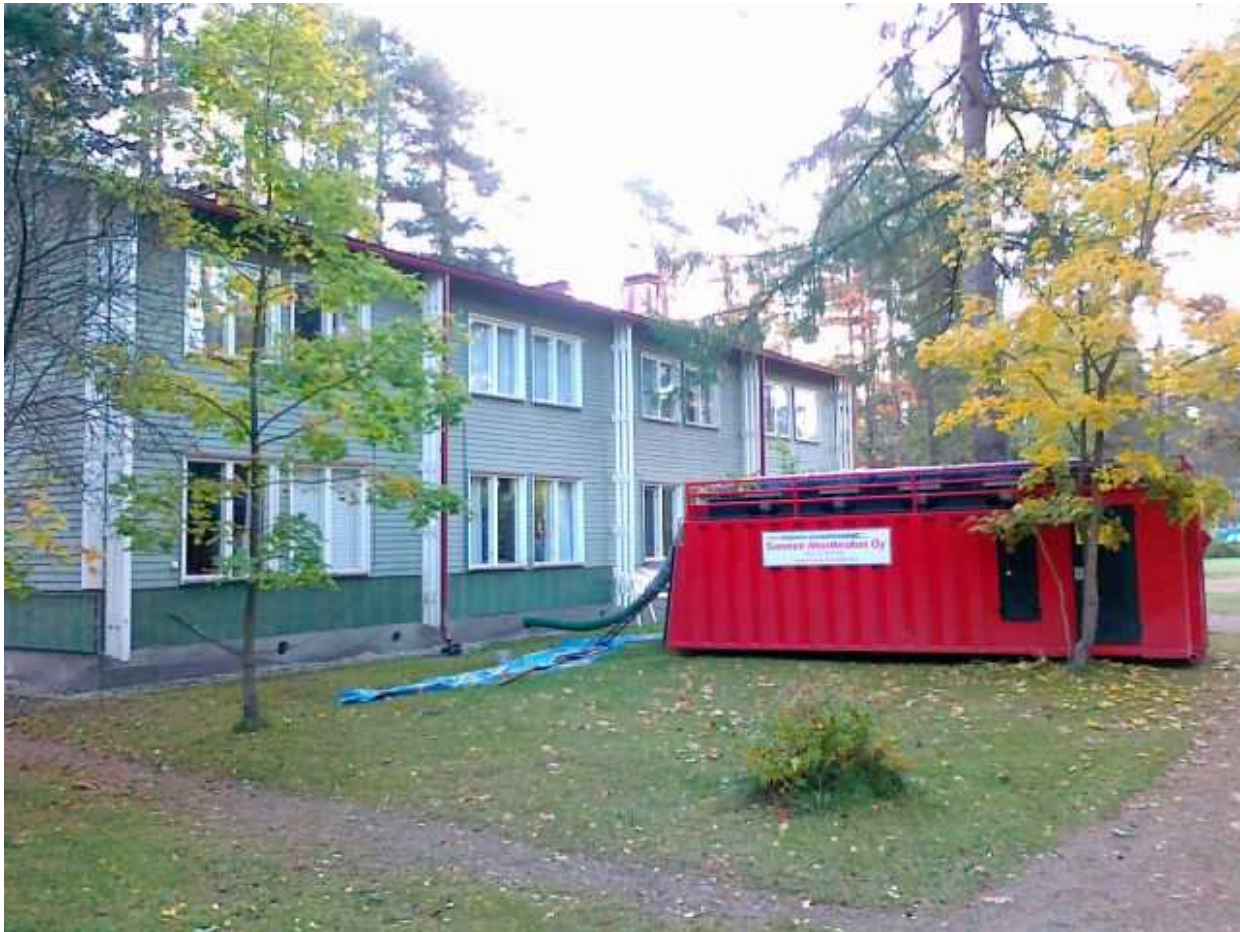
KUVA 8. Suurtehoimuri. Kuvassa imetään purueristettä alapohjasta suurtehoimurilla. Valokuva Mika Laukkanen 2010.
