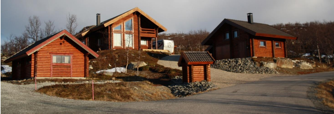
Kuvio 41. Rakentamisen jäljet on huolellisesti viimeistely kuntalla ja luonnonkivillä Salmivaarassa (Jenni Yrjänheikki)
