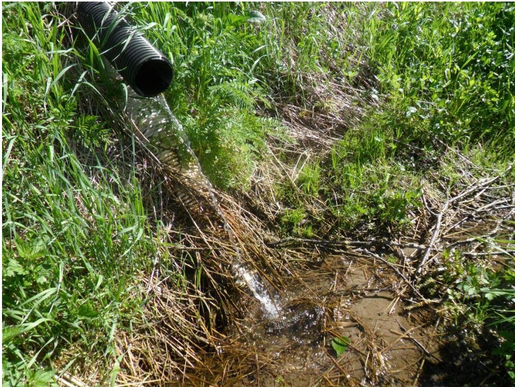
KUVA 18. Näytteenottopiste 2. Ensimmäinen poistoputki järven rannasta maalle päin toukokuun 2013 lopussa. Valokuva Tanja Tikkanen 2013
