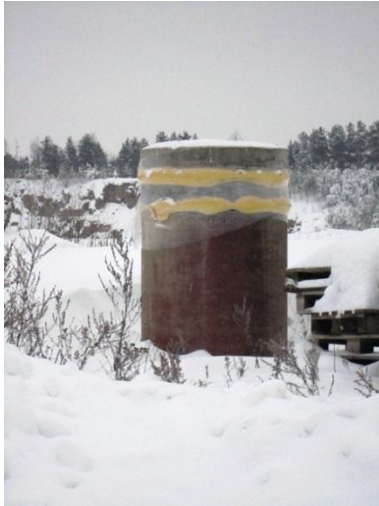
KUVA 5. Tiivistetty kaivo (Salmi 2013).
