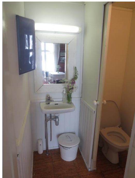
Kuva 5. WC muutoksen jälkeen
