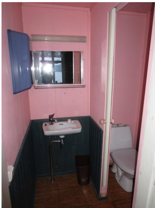
Kuva 4. WC ennen muutosta
