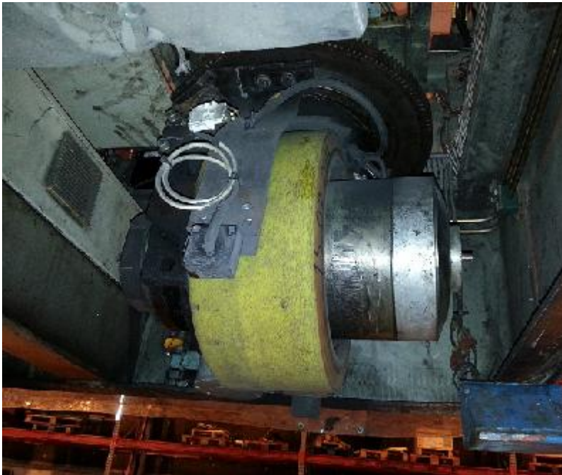
Kuva 33. Kääntökehän kunto tarkistetaan silmämääräisesti.
