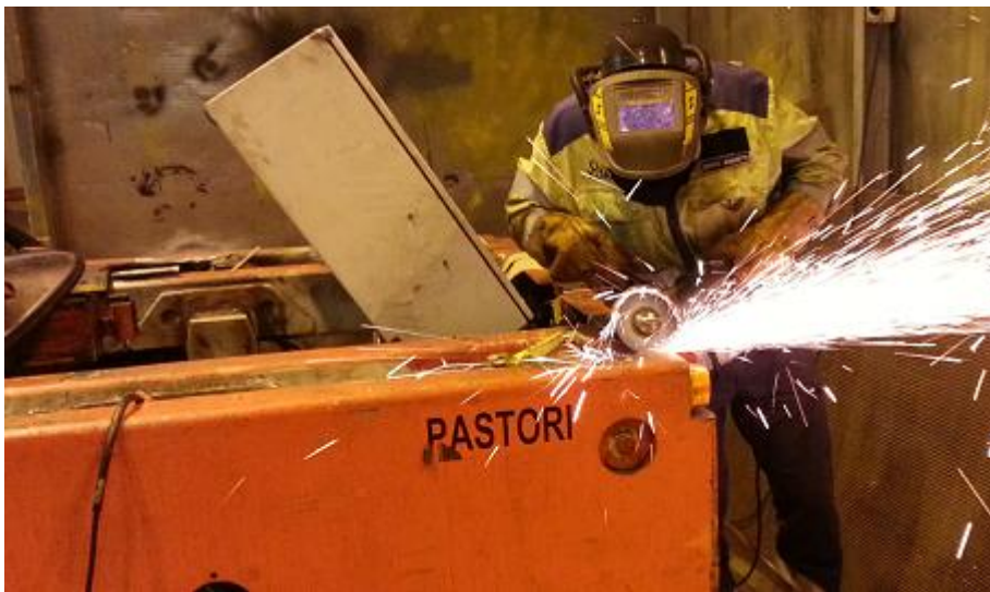
Kuva 36. Runkorakenteen hiomista kulmahiomakoneella.
