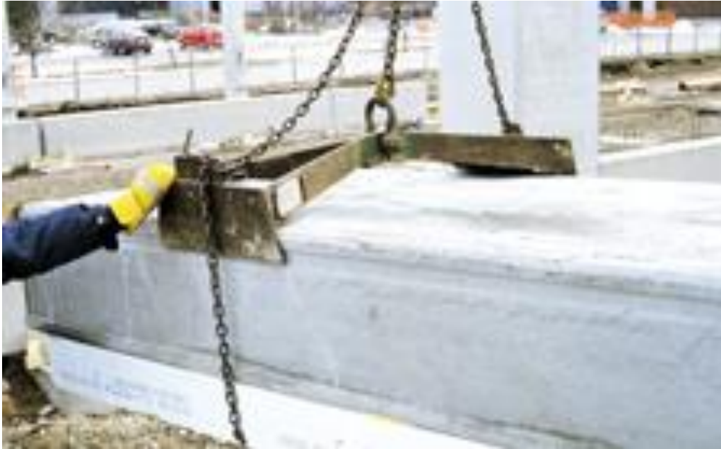
Kuva 4. Ontelolaattatyöt käynnissä. Nostettaessa käytetään varmuusketjua. [7, s. 9]
