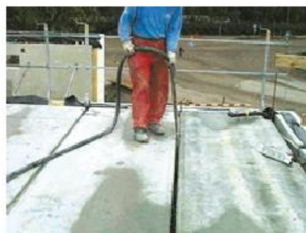
Saumavalubetoni tiivistetään aina suuvatäryttimellä sauman lujuuden ja ääneneristävyyden varmistamiseksi.
