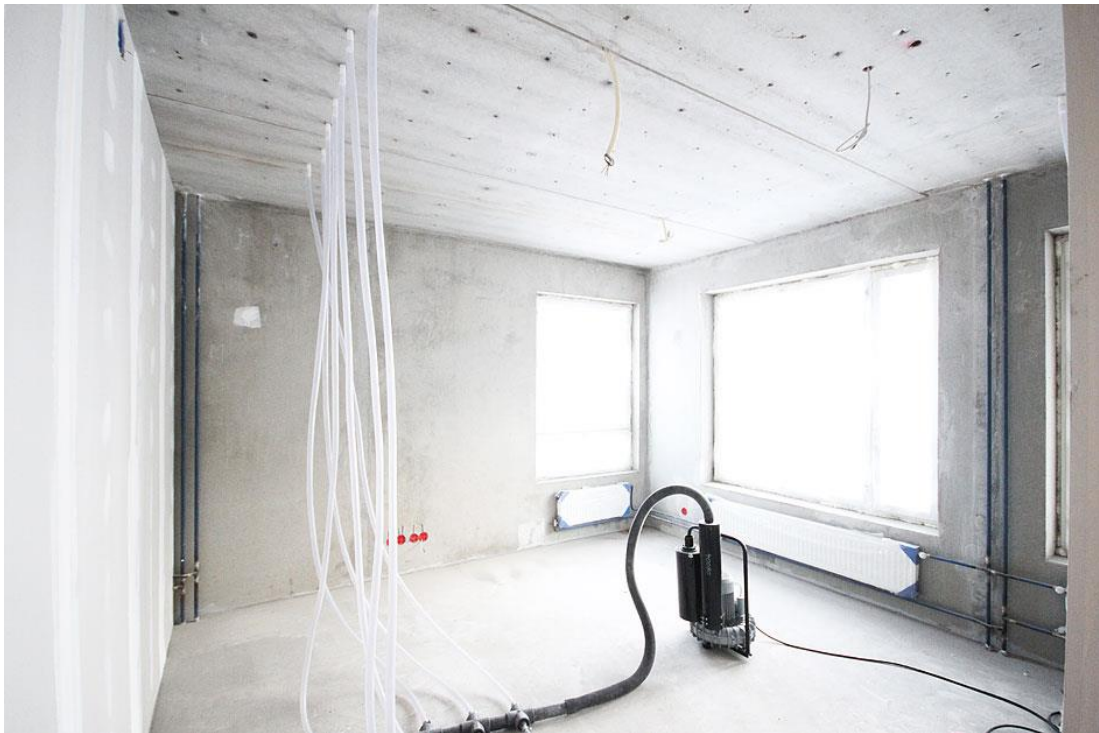
Kuva 11. Ontelokuivausta voidaan tehdä erilaisilla kuivauskalustoilla. [14]
