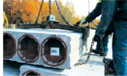
Varmusketjun voi kuormassa kiinnittää ennen laatan nostoa, kun vierekkäiset laatat siirretään erilleen.
