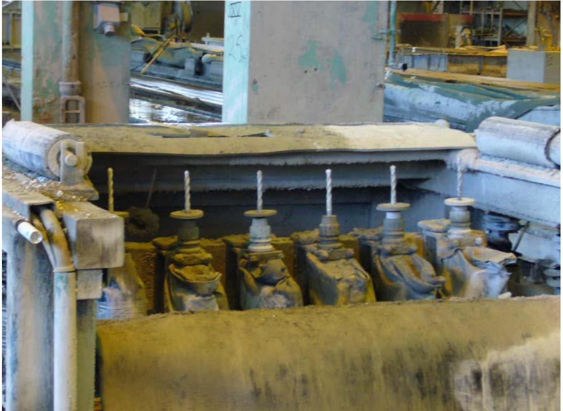
Kuva 3. Onteloreikien poraukseen käytetään telineeseen sijoitettuja porakoneita [6, s. 13].
