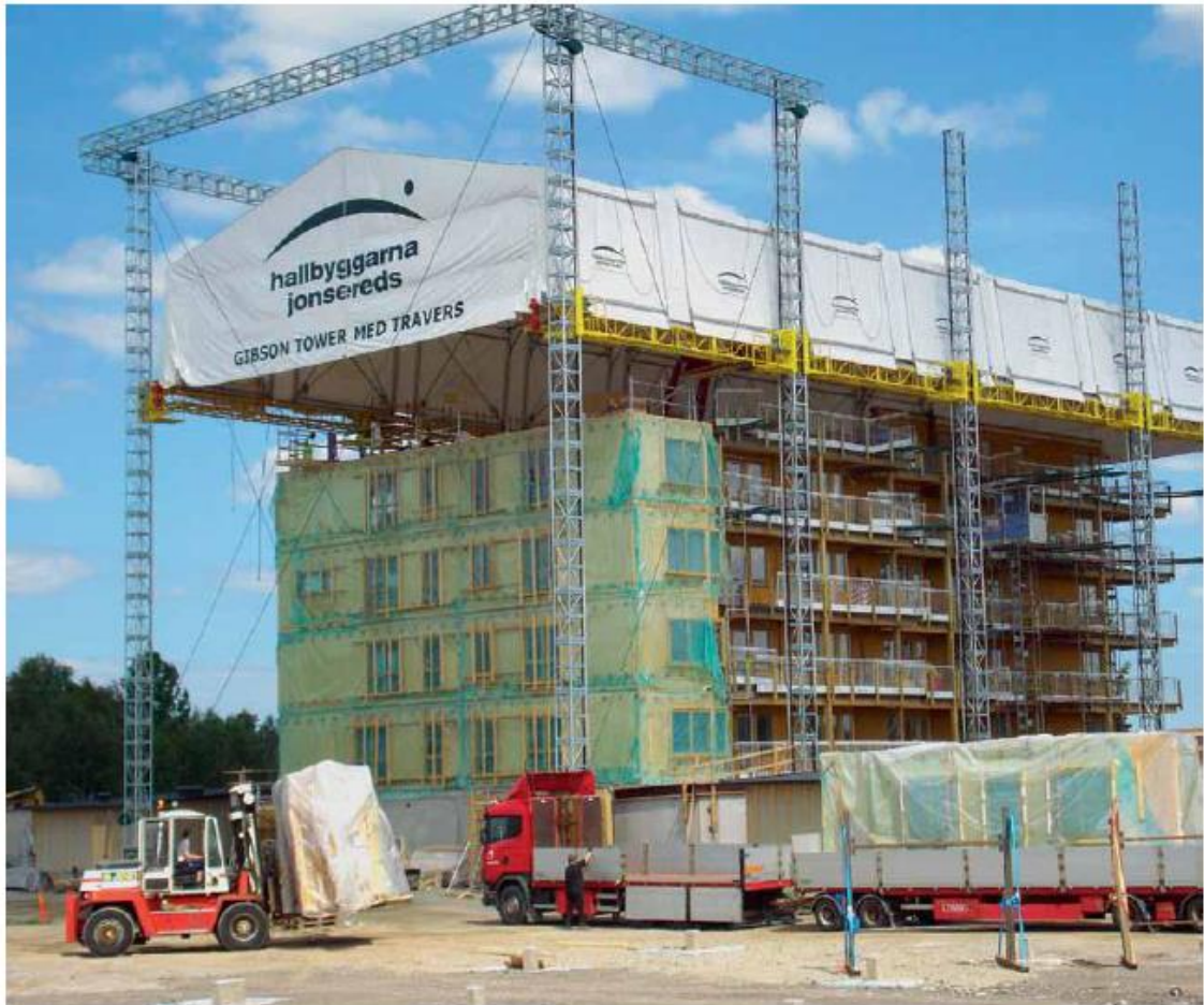
Kuva 13. Nouseva säsuojaratkaisu. Kate nousee ja laskee moottoreiden avulla. [16, s. 24]
