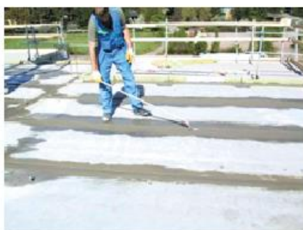
Valuroiskeiden poistaminen ja sauman viimeistely on helpointa tehdä ennen betonin kovettumista.
