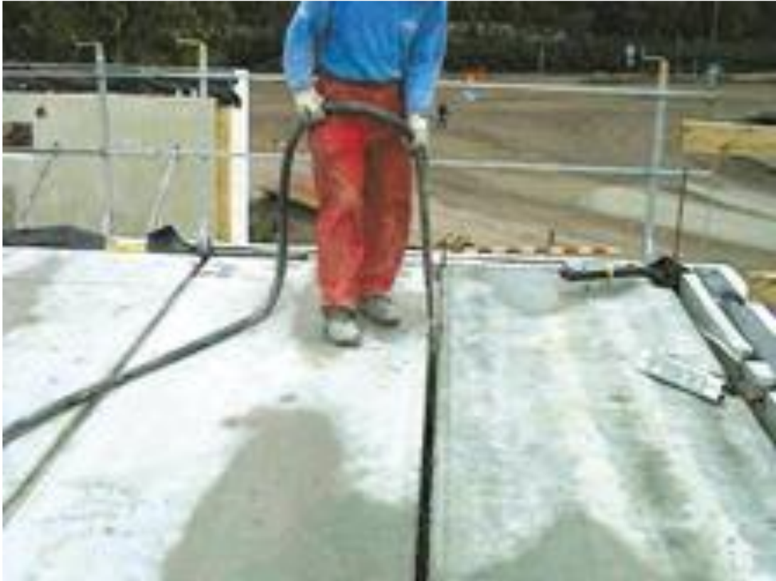
Kuva 5. Saumavalu tiivistetään sauvatäryttimellä. [7, s. 19]
