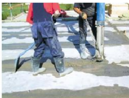
Kun valusuppilon kanssa käytetään valusukkaa ja anostelulaitetta, varmistuu sauman täytyminen ja jälki-työt vähenevät.
