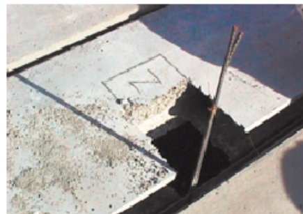
Nostokannakset on merkitty lattaan N-merkinnöillä. Ne voi poistaa saumavalujen kovettumisen jälkeen.
