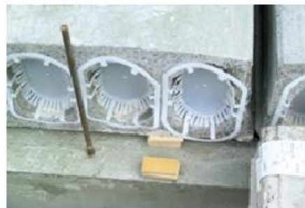
Asennuskorokkeiden paikalleenmittauksessa otetaan huomioon sekä korkeusasema että sivusijainti.
