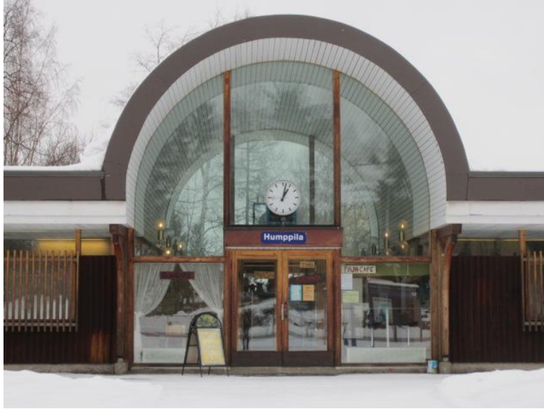
Kuva 4. Humppilan asemarakennus, Työpaja Asematupa
