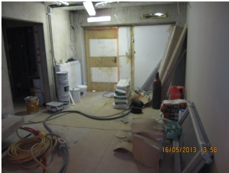
Kuvio 8. Työmaalle sisään tulo
