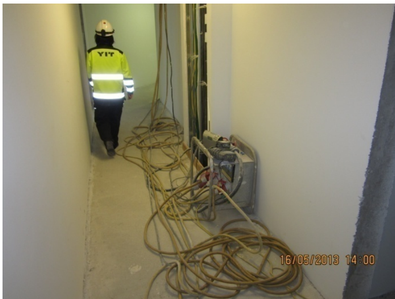
Kuvio 9. Työmaan sähköistys
