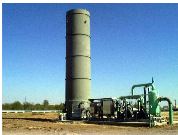
Kuva 9. Suljettu soihduttu [MRV technologies].
