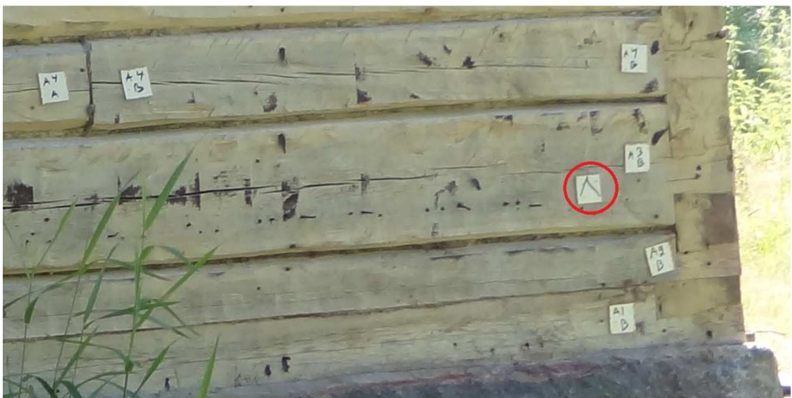
Kuvio 27. Korkeusmerkinnät tehtiin hirsirunkoon tasaisin välimatkoin, jotta runko saatiin kasattua samaan asentoon uudessa paikassa.
