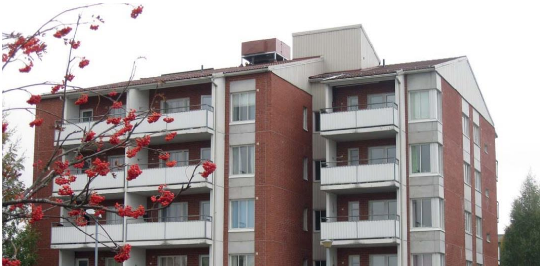
KUVA 7. Kattoyksikkö, jossa harjalämmönsiirtimellä toteutettu patteri.
