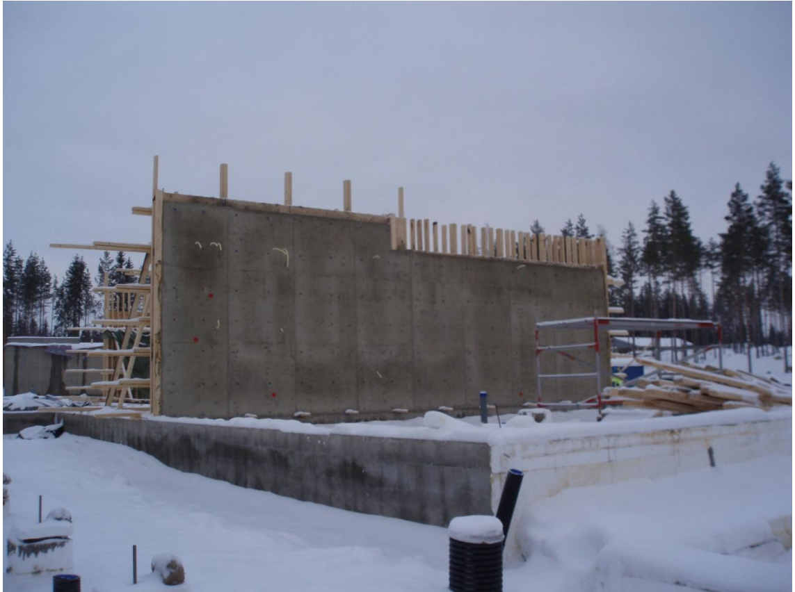
KUVA 3. Paikallavalettua seinää, josta vaaleammalla värillä havaittavissa lämpölankojen paikat.
